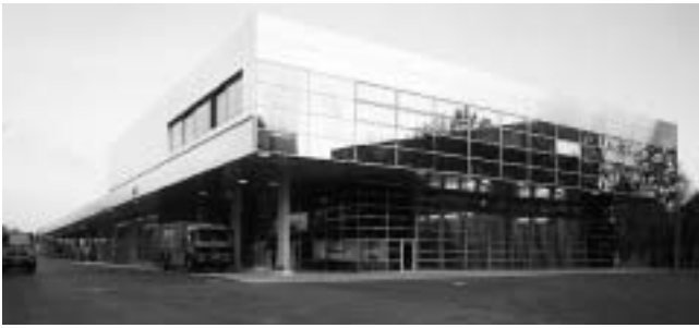
Der Kopfbau von der Einfahrt aus: Hier sitzen die verspiegelten Fenster der Verwaltungsräume bündig in der Fassade, sie scheinen Teil der silbern glänzenden Aluminiumhaut zu sein.
