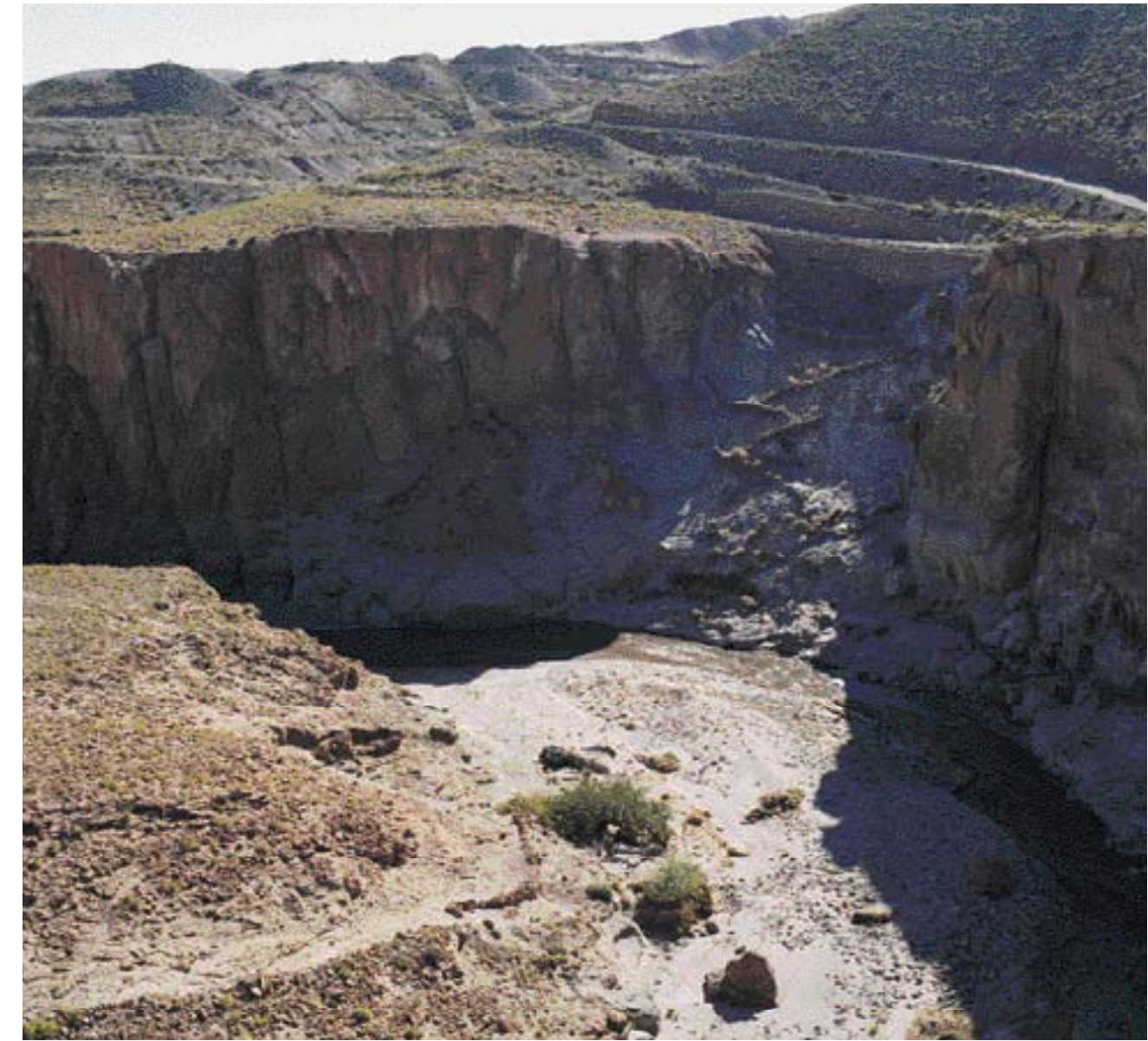
Para que el camino sorteara el cañón del río Salado, tributario cordillerano del río Loa, se construyó un sistema de aterrazamientos en zigzag que baja por una empinada ladera.
