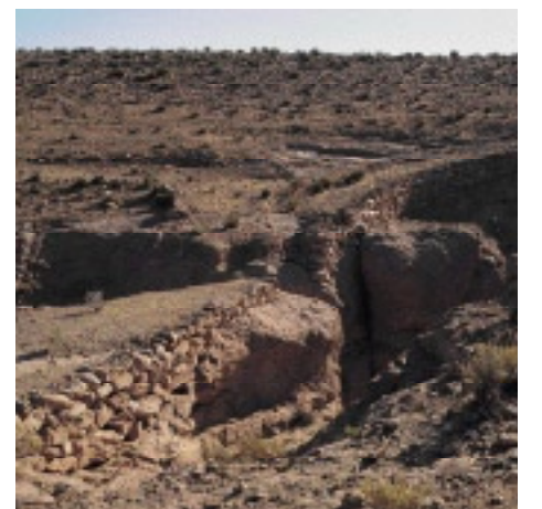
Cerca de Caspana (río Loa Superior) aún se conservan los terraplenes de un puente Inka.
