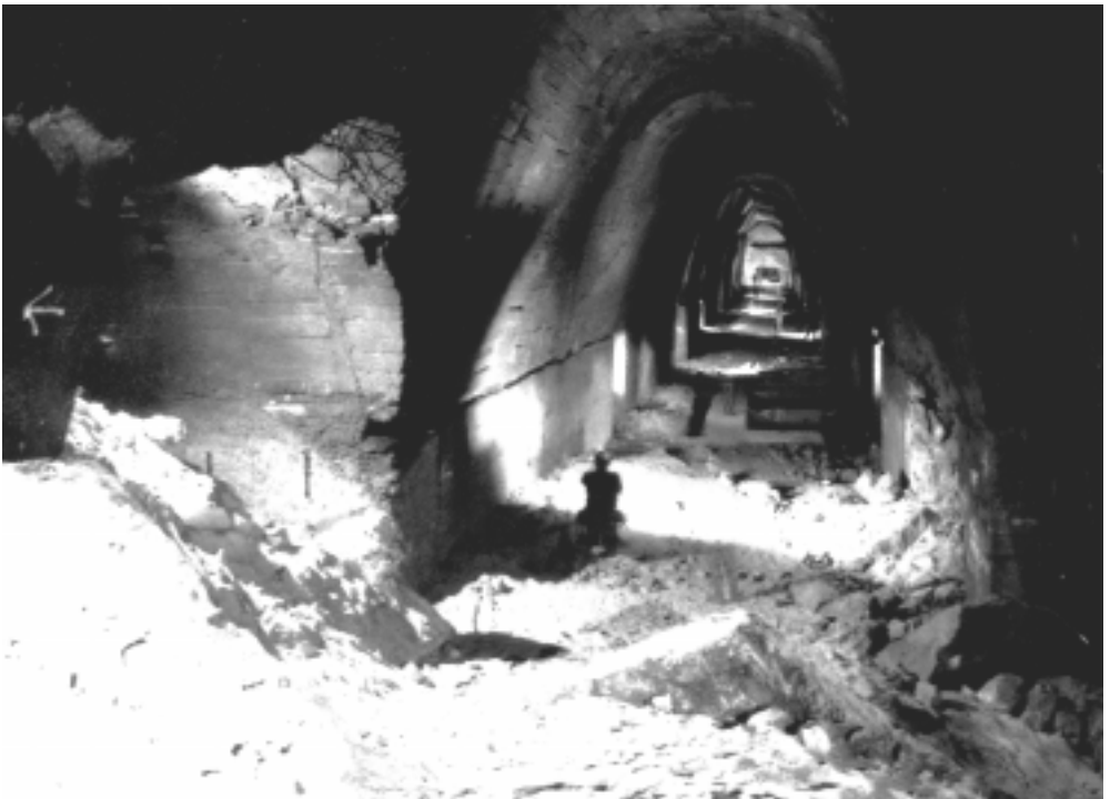
Betonierter Hauptstollen der Steyr-Daimler-Puch AG
