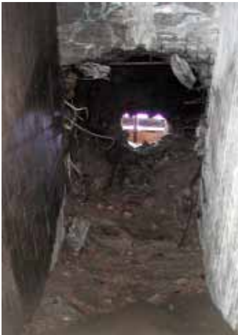
Durchbruch von unten
