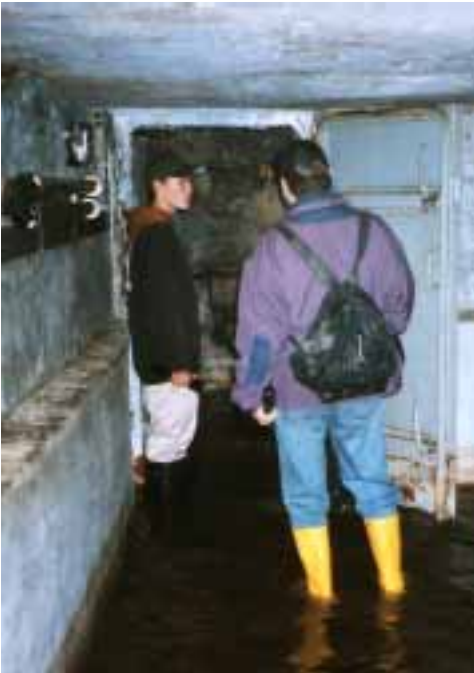
Bei der Erkundung des Kampfgruppenbunkers.
