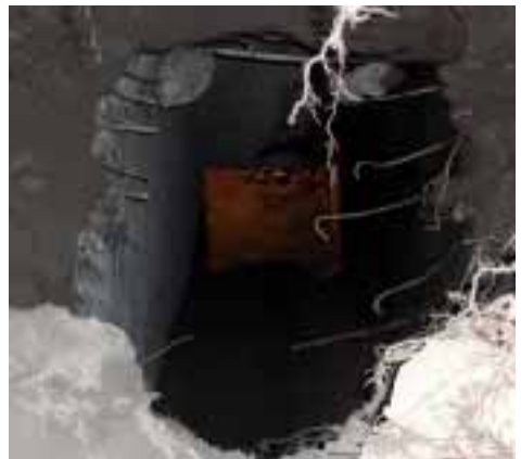
Durchbruch von oben
