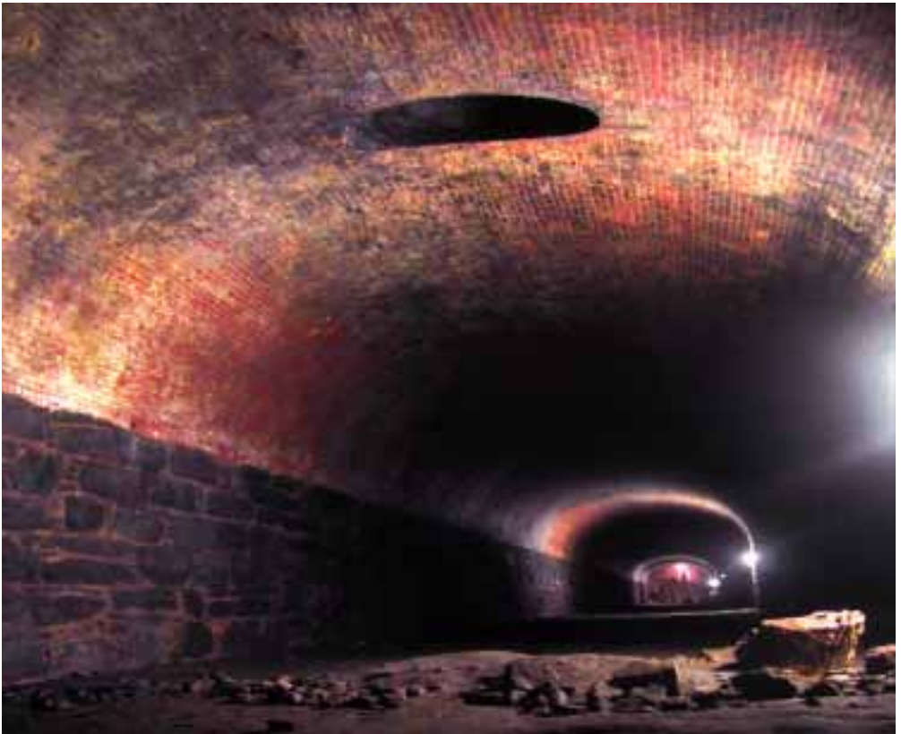
Der Schauplatz der Premiere von Ars Subterranea – der Atlantic Avenue Tunnel.
