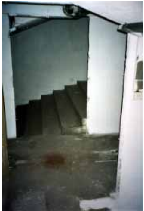
Blick aus dem einen Treppenhaus in das gegenläufige Treppenhaus im Zombeckturm
