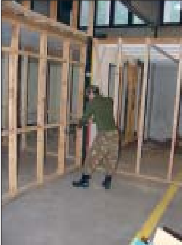
Rivningen av gamla skrivarrummet i full gång.
