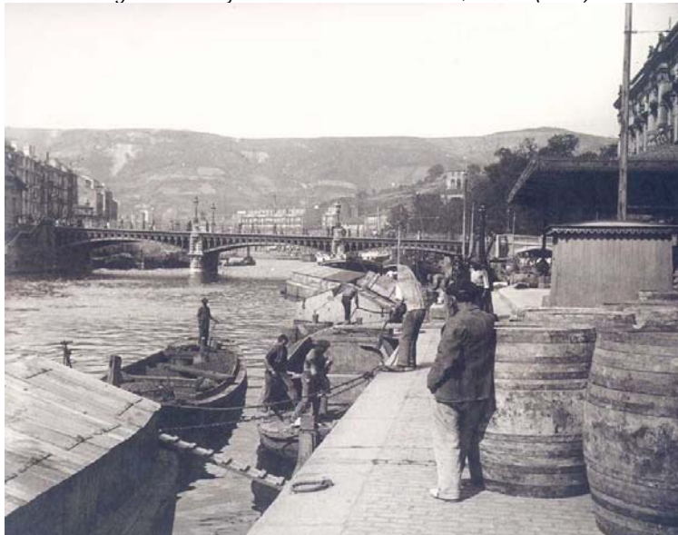
Fig. 1.2.-Trabajos en el Muelle del Arenal, Bilbao (1905)
