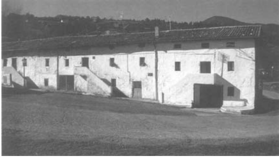
Fig. 2.13.- Inmuebles de la Cia. Orconera en los Montes de Triano, utilizadas originariamente como cuadras
