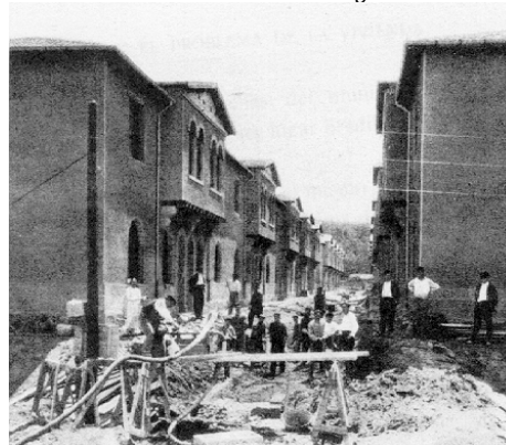
Fig. 5.8.- Obras de edificación del Hogar Obrero, Guecho
