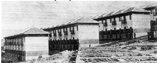
Fig.5.36.- Vista lateral de las viviendas de los Obreros de Castrejana y su desmonte, Bilbao
