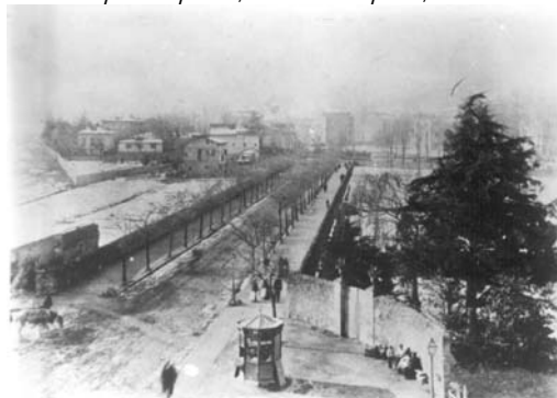
Fig.1.5.- Prolongación de la Gran Vía (1869). En primer plano, la Plaza Elíptica, Bilbao
