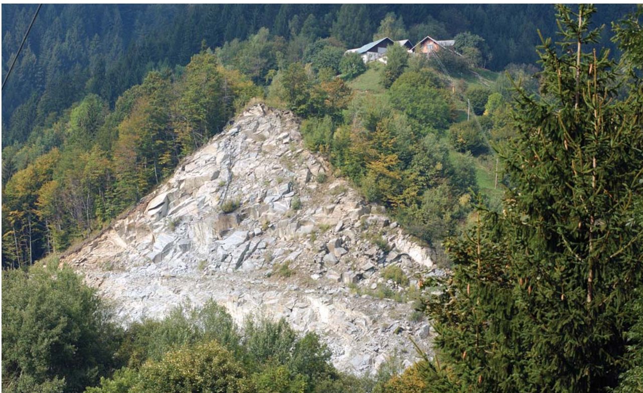
Slika 1: Kamnolom Cezlak I se je že nevarno približal kmetiji nad njim, zato je nadaljnje pridobivanje kamna horizontalno omejeno (foto: Domen Grögl).
