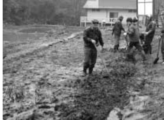
水路の改修作業 (2001/03/25)
