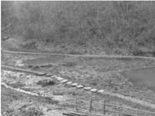
飛び石と土盛りによる観察道 (2001/03/02) 土盛り道で水を誘導する。
