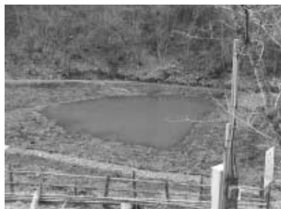
蛇籠籠上に土が盛られた1号池 (2001/03/02) ほぼ、基盤地形は完成。
