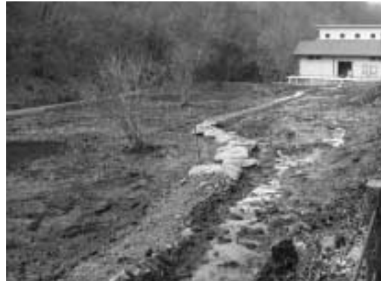
飛び石と土盛りによる観察道 (2001/03/02) 管理棟はほぼ完成。
