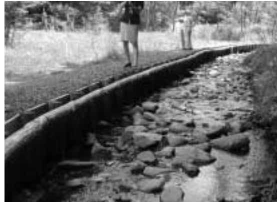
用水路の状況 (2001/10/06) 割石が落ち着き、魚類も生息するなど自然性が実現できている。
