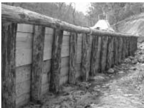
マツ杭と板による用水路 (2001/02/10)
