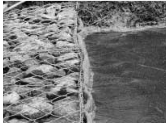
蛇籠籠の全面に付けられた吸い出し防止マット この時点では、土は盛られていない。(2001/02/10)
