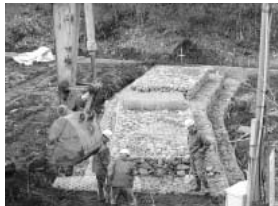
蛇籠籠による堰堤構築作業 (2001/02/10)
