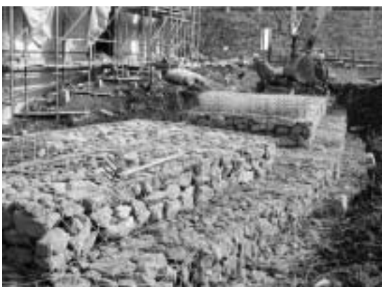
蛇籠籠による堰堤構築作業 (2001/02/10)
