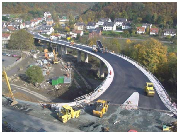
Bau der Ortsumgehung Biedenkopf-Wallau (B 62)
