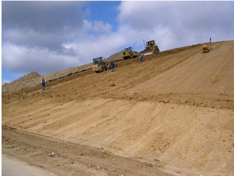
Rekultivierung der Deponie Gießen-Allendorf: Herstellung der Oberflächenabdichtung
