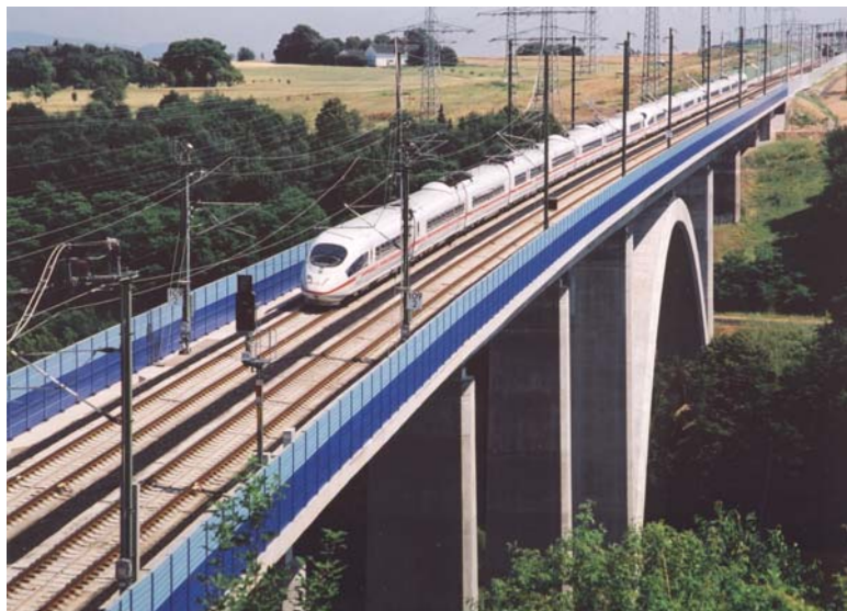
Lahntalquerung bei Limburg, Foto: DB Netz AG
