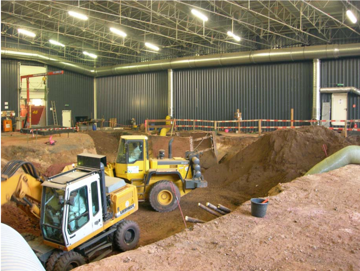
Sanierungsarbeiten unter der Einhausung Kinzigstraße.
