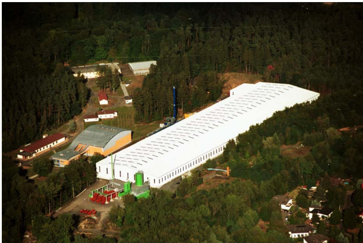
Die rund 250 Meter lange Einhausung der Trihalde - links davon das Wasserwerk
