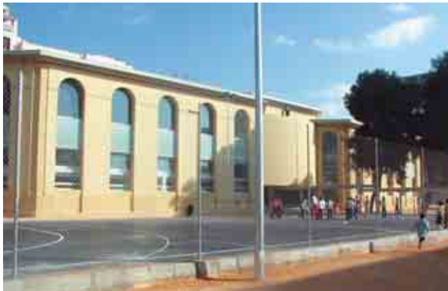
Fachada posterior del edificio.
