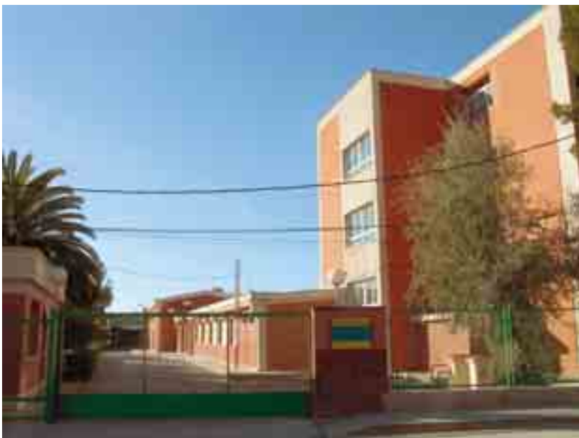
El I.E.S. La Melva, que desde 1968 albergó la Escuela de Aprendizaje Industrial, fue reformado integralmente a principios de los años 90.
