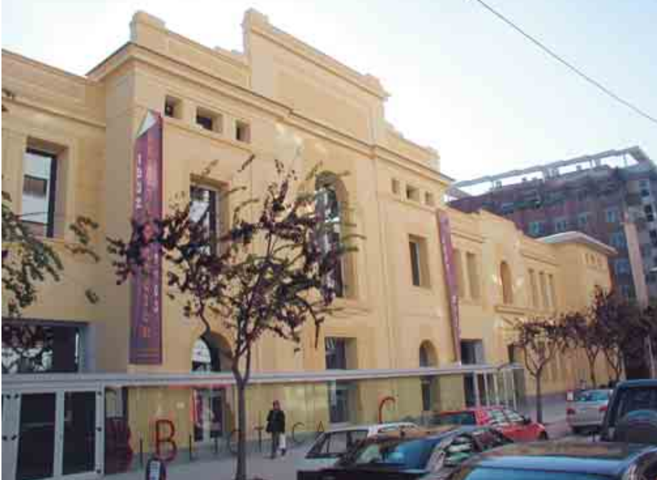
Fachada delantera del colegio tras la rehabilitación.
