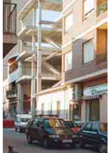
Casa de planta baja en la calle Maestro Estruch atrapada entre nuevos edificios en construcción.
