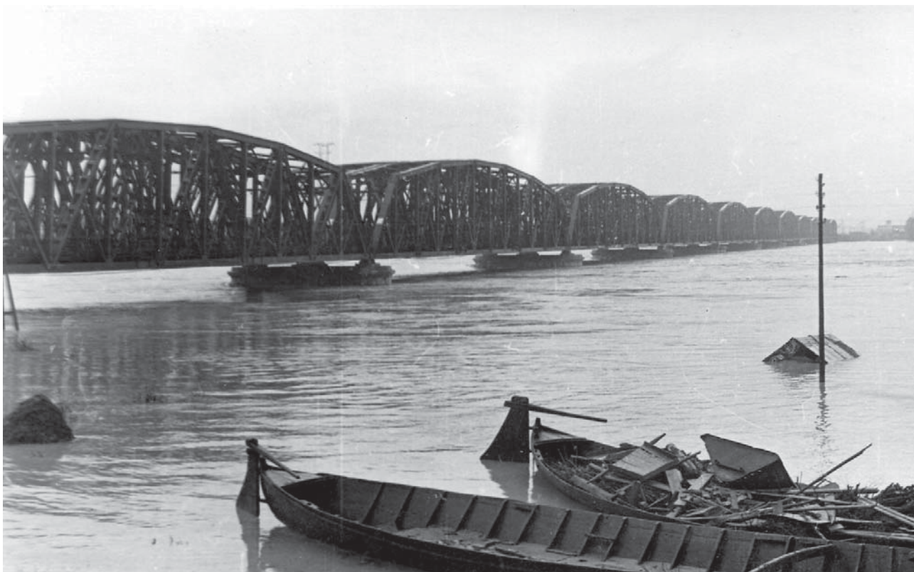
Piena del novembre 1951: le acque sfiorano il ponte ferroviario.
