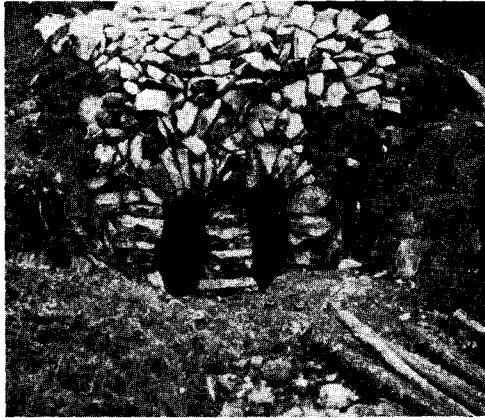
Kuva 31. Alkuperäinen kalkinpolttomaauuni. Vimpeli—Alajärvi. Vesterpakka. Valok. Aarne Laitakari 1929.
