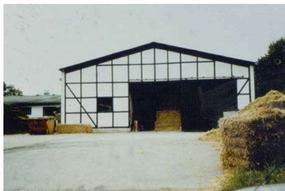
Bild 9 Feuergefährdeter Bereich „Scheune“
