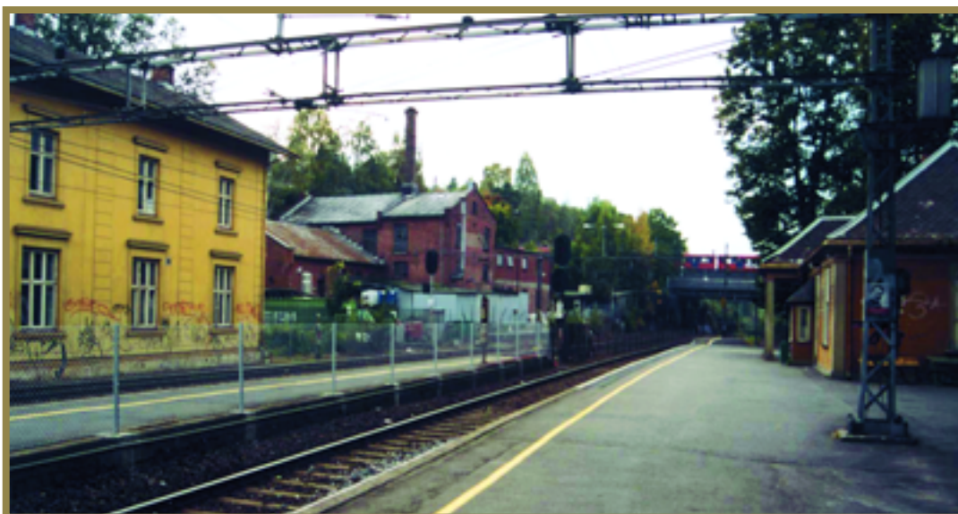
STASJONSOMRÅDET PÅ BRYN MED BYGNINGEN SOM TILHØRTE ERLANGER BRYGGERI I BAKGRUNNEN, STASJONS- MESTERBOLIGEN FRA CA. 1880 TIL VENSTRE OG STASJONSBYGNING FRA 1902 PÅ DEN ANDRE SIDEN.
