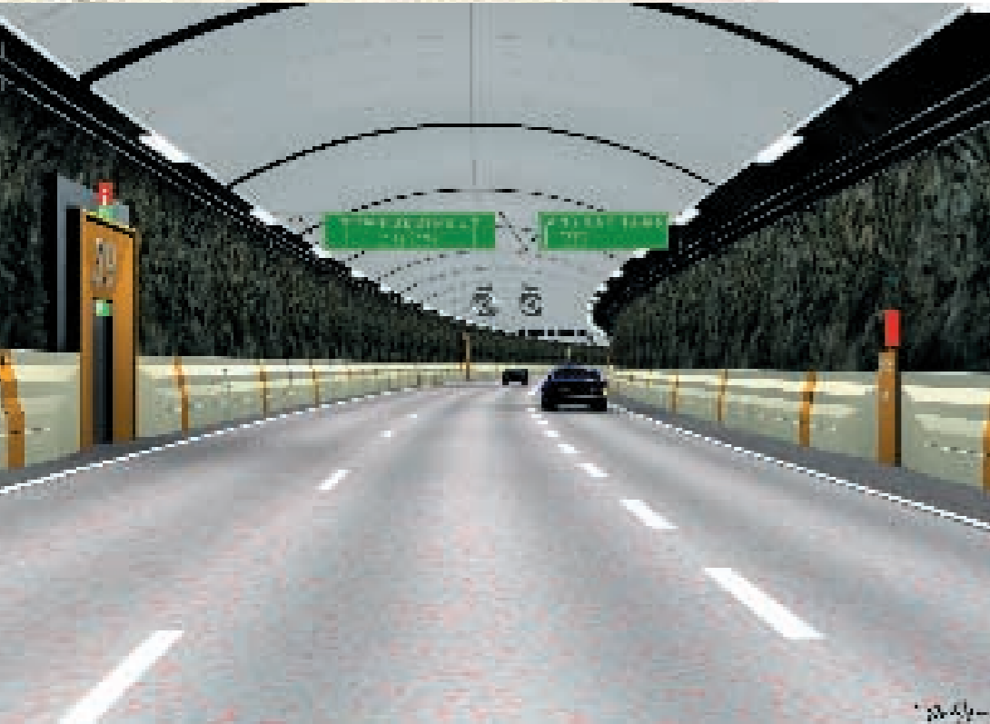
Södra Länkens tunnlar förses med ljust innertak och ljusa körbanor för ökad säkerhet och komfort.
