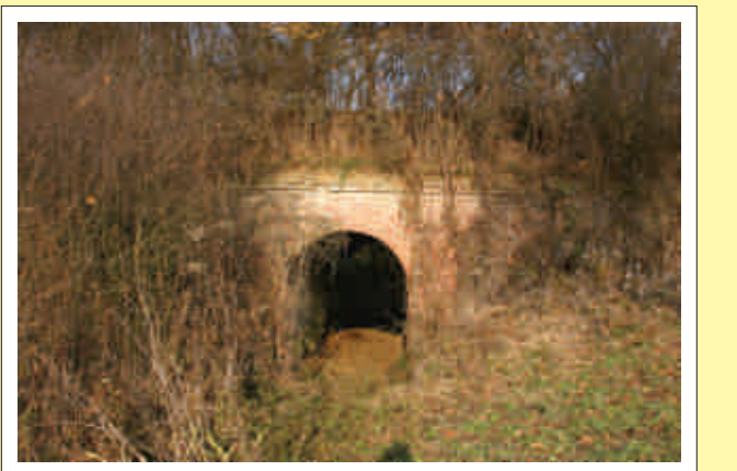
Gewölbebogen bei Grabendurchlass - Rest der alten Bahnlinie
