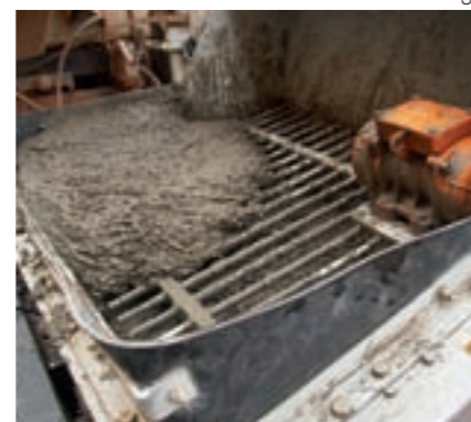
Fahrer beschicken die kleine P 715 Spritzbetonpumpe
