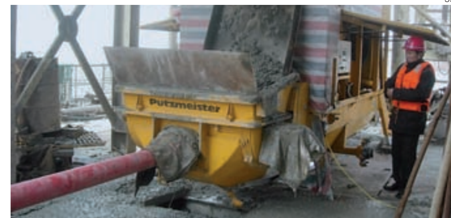
Eine PM Hochdruckpumpe BSA 14000 HP-D unter der Mischanlage. Man beachte die Beton-„Schüttung“
