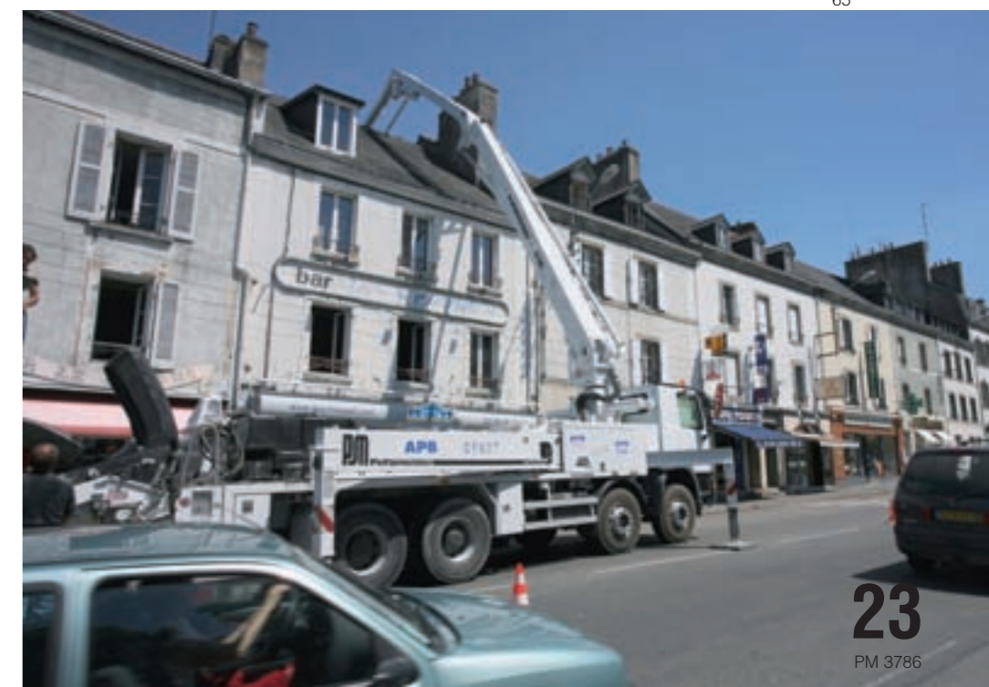
Über das Dach des Hauptgebäudes an der Straßenfront hinweg steuert Monsieur Boisbunon den Verteilermast seines M 38-4 durch das Fenster des Nebengebäudes
