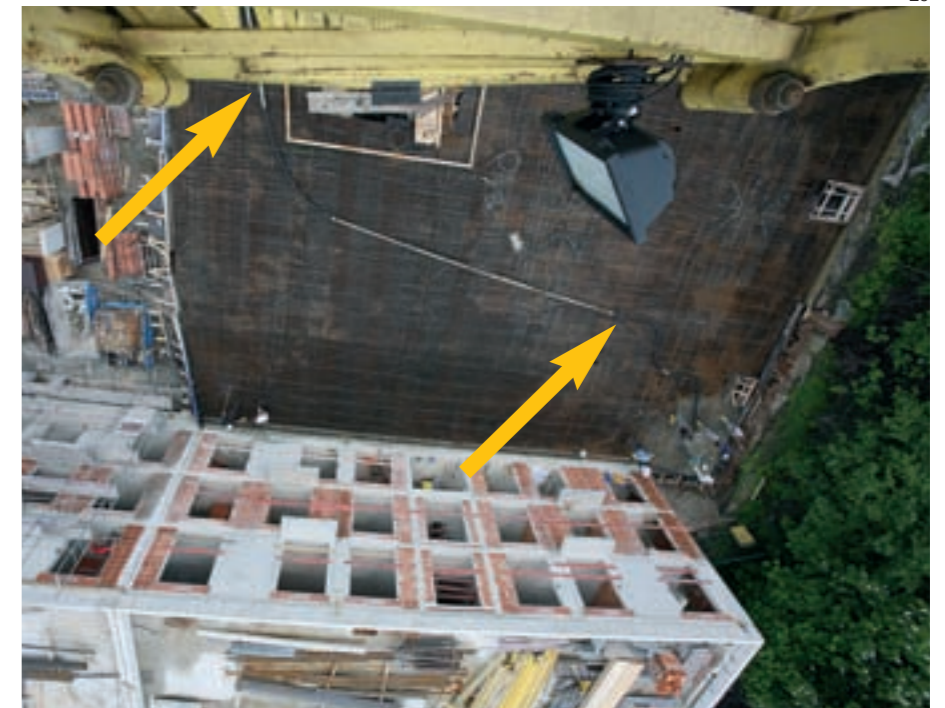
Der Betoneinbau erfolgt weit hinter der Gebäudefront
