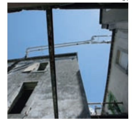
Über das Dach des Hauptgebäudes an der Straßenfront hinweg steuert Monsieur Boisbunon den Verteilermast seines M 38-4 durch das Fenster des Nebengebäudes
