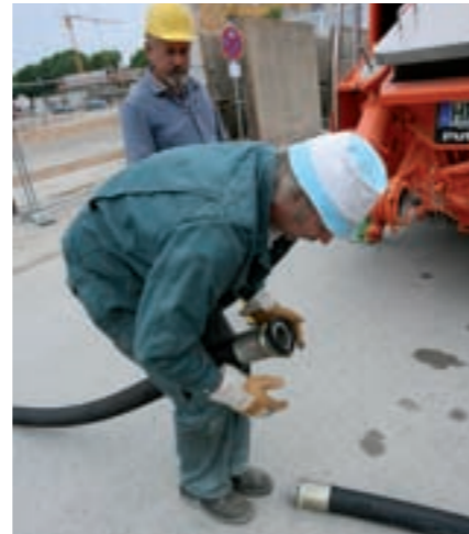
An den um 180° geschwenkten Klappbogen werden Reduzierungen für die 65er Förderschläuche angeschlossen
