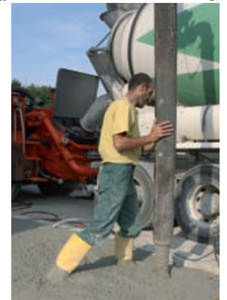
Betoneinbau in die Bodenschalung
