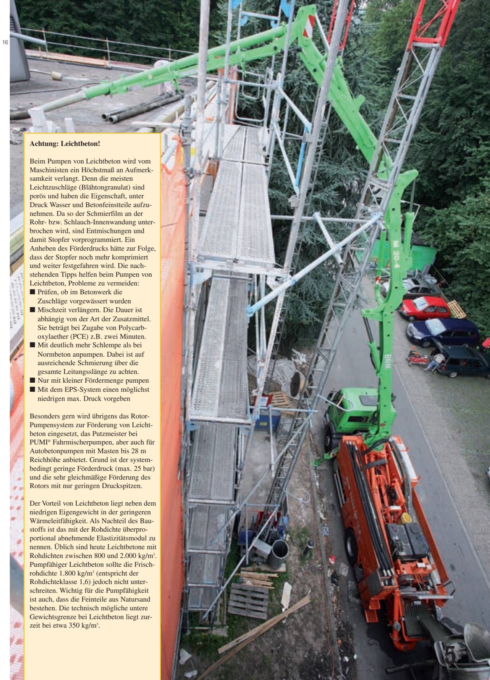
Das EPS-System ermöglicht das Einstellen des maximal gewünschten Hydraulikdrucks (und damit zwangsläufig auch des Betondrucks)
