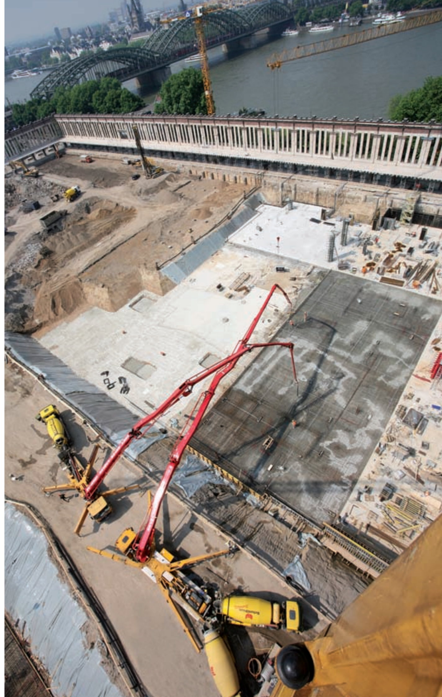
Mit dem 200 m 3 /h-Aggregat des BEKA M 62-6 lässt sich „richtig Menge“ pumpen!
