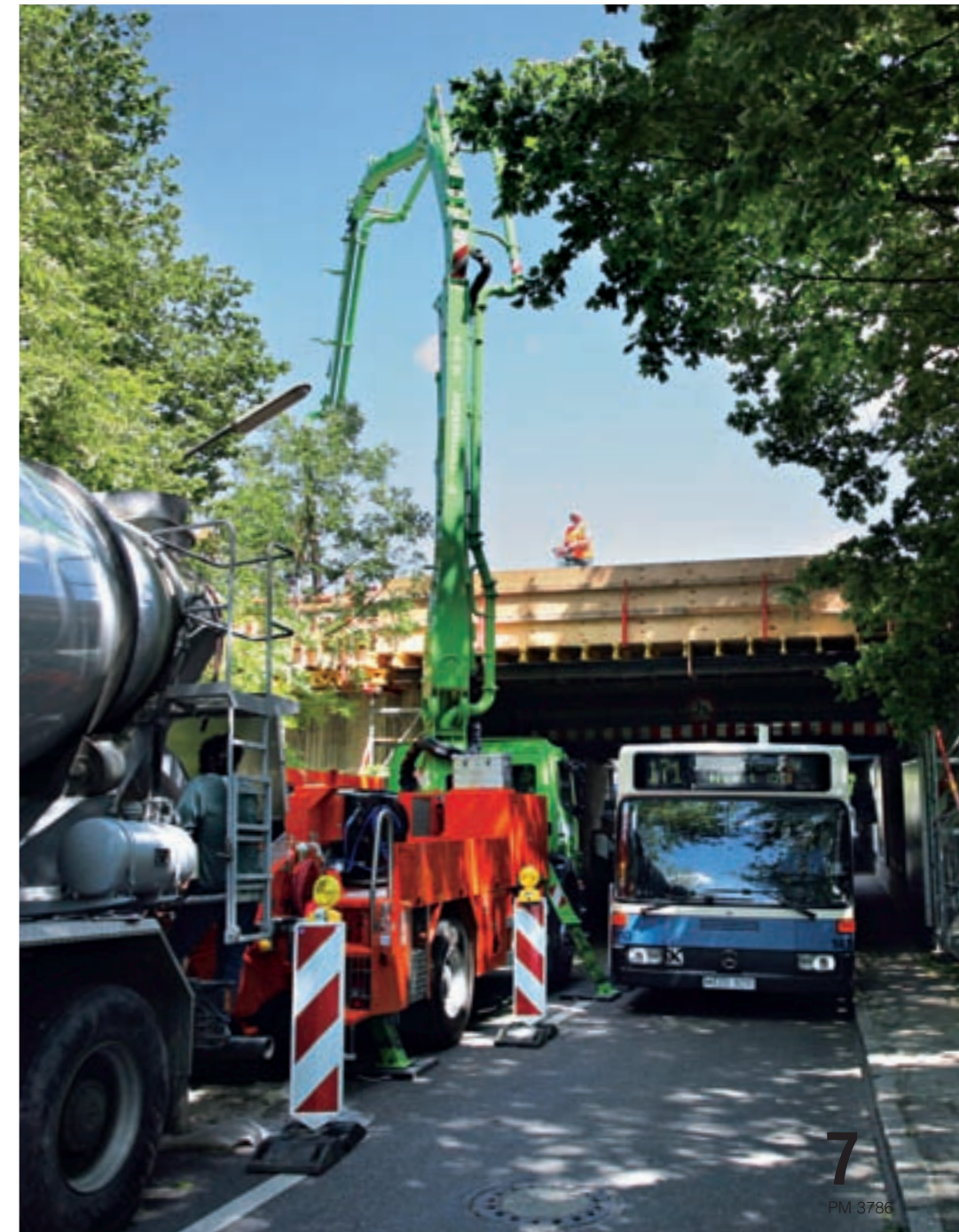
Betoneinbau in die Bodenschalung
