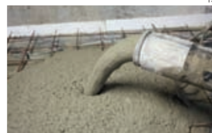
Der Leichtbeton tritt mit vollem Strahl aus der 65er Schlauchleitung aus
