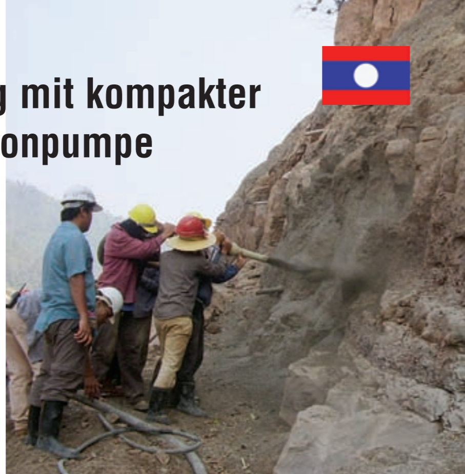
Gleichmäßiger Spritzbetonauftrag sichert die Berghänge
