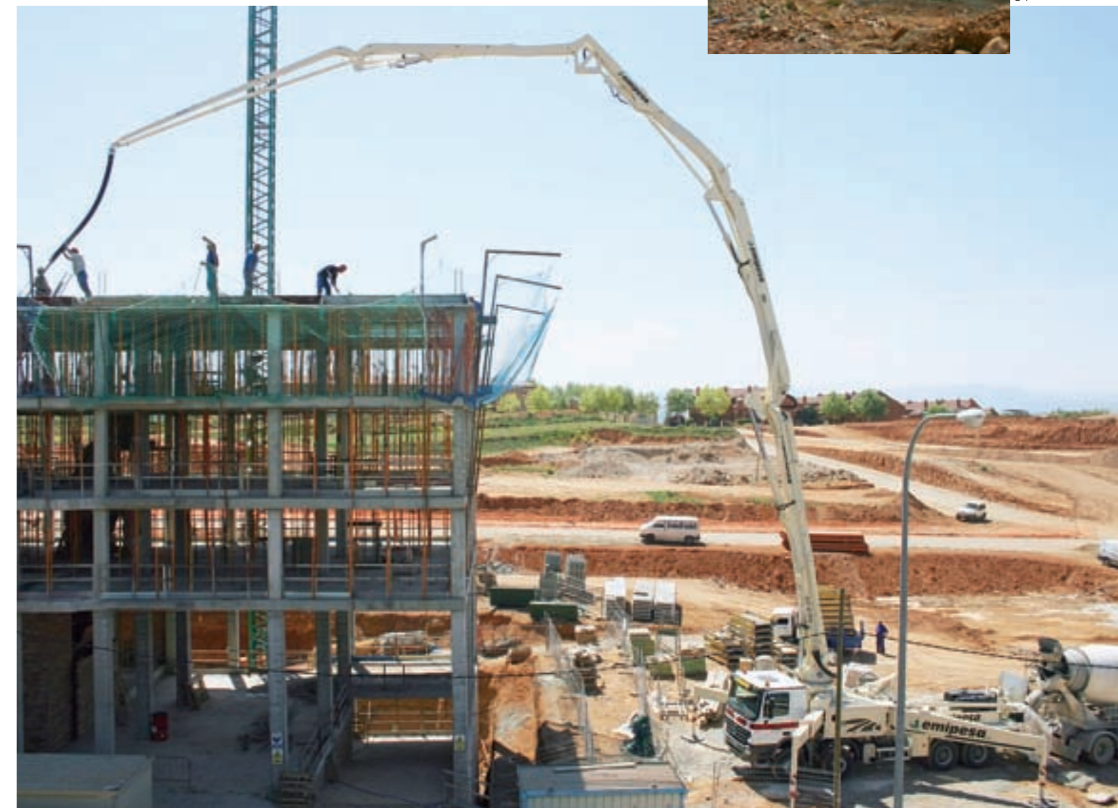
Hoch und weit – ein Fünflings-Mast passt sich leicht den unterschiedlichsten Gebäudeprofilen an
