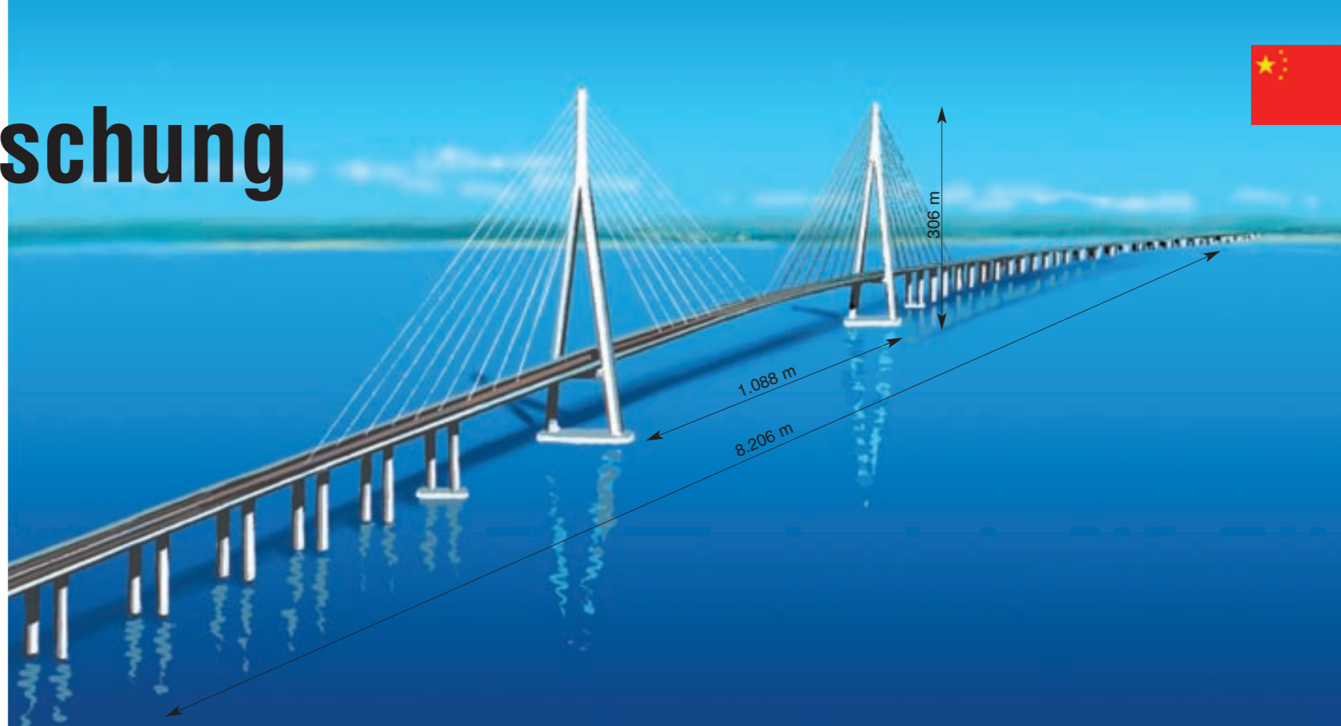
Modell der riesigen Sutong-Schrägseilbrücke
