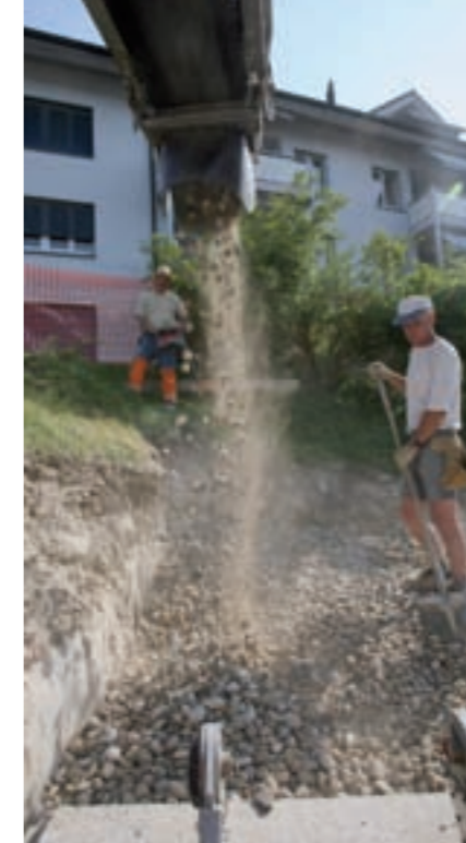
Punktgenau verfüllt das Teleskopband den Zwischenraum zwischen Hang und Kellerwand
