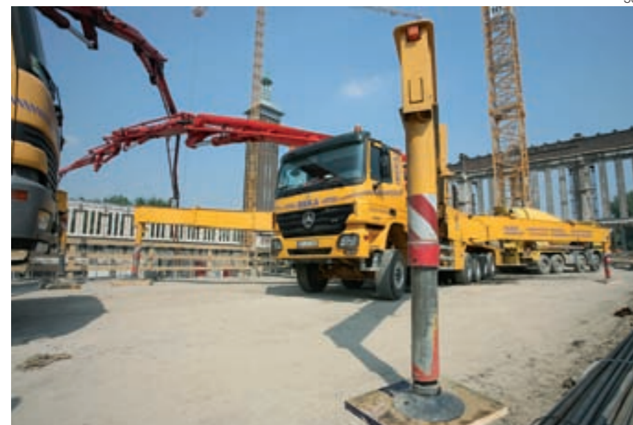
Die vordere Teleskopabstützung der PM Großmastpumpe führt nach kurzem Ausschwenken auf direktem Weg zum Abstützpunkt
