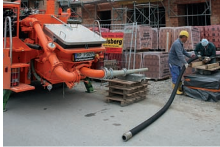
An den um 180° geschwenkten Klappbogen werden Reduzierungen für die 65er Förderschläuche angeschlossen
