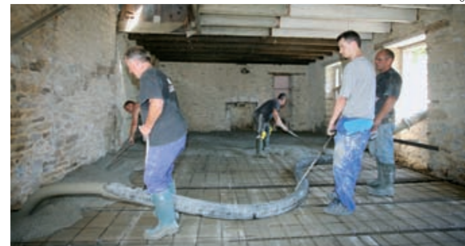
Betoneinbau in die Decke eines Altbaus
