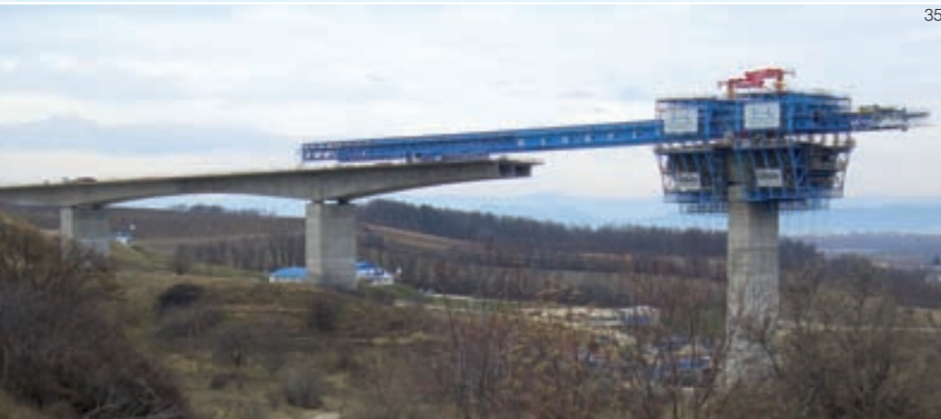
Der Brückenüberbau wird mit Vorschubgerüsten in 11 m langen Abschnitten erstellt
