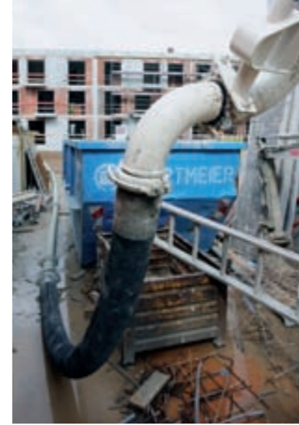
Anschluss der Verlängerungsleitung an die Mastspitze
