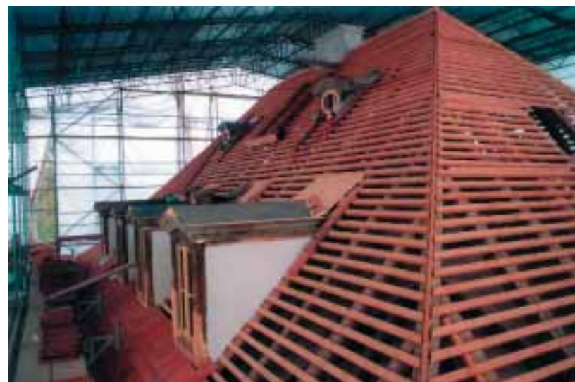
ABB. 15 Schloß Tiefurt, Dach nach der Sanierung der Dachkonstruktion und der Gaupen
