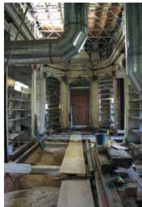
ABB. 3, 4 Herzogin Anna Amalia Bibliothek, Einbau der Stahlträger zur Aufnahme der Stützen der Holzkonstruktion des Rokokosaales
