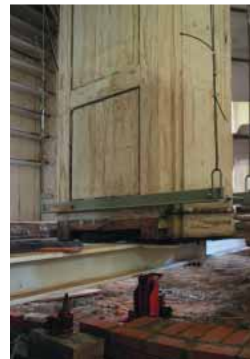
ABB. 3, 4 Herzogin Anna Amalia Bibliothek, Einbau der Stahlträger zur Aufnahme der Stützen der Holzkonstruktion des Rokokosaales
