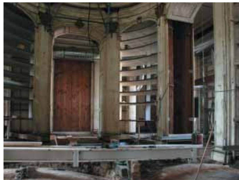
ABB. 2 Herzogin Anna Amalia Bibliothek, Blick in den Rokoko- saal nach dem Ein- bau der Stahlträger über den Erdge- schoßgewölben
