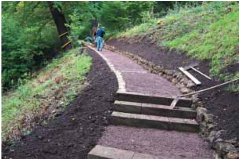
ABB. 5 Wegebau im Hangbereich des Tiefurter Parks
