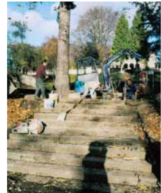
ABB. 3 Neuversetzung des Treppenlaufs unterhalb der »Villa Haar«
