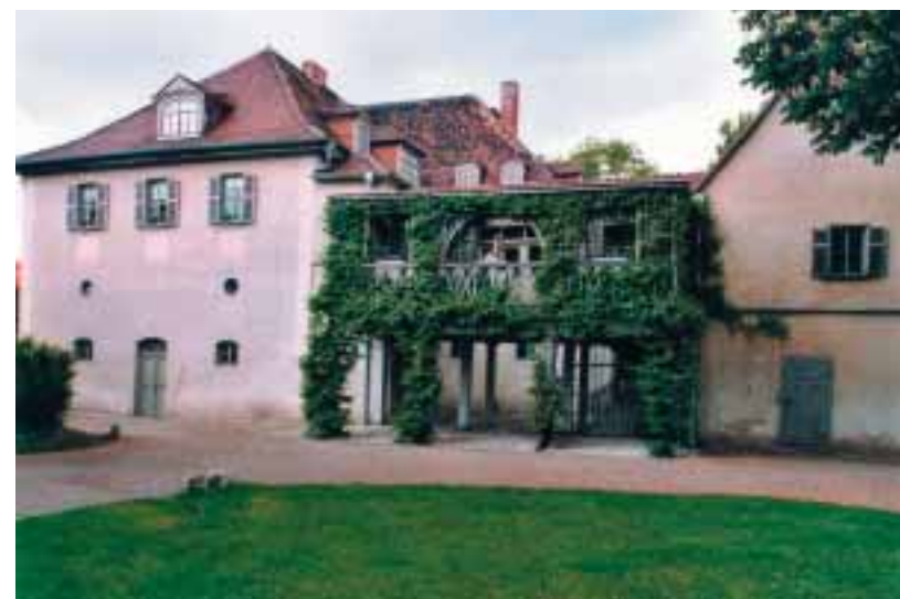
ABB. 13 Schloß Tiefurt (Ostansicht) vor Beginn der Sanierungsarbeiten
