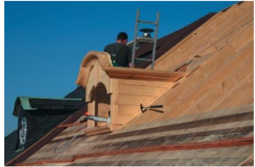
ABB. 10 Herzogin Anna Amalia Bibliothek, Aufbau der Dach- gaupen auf dem wiedererrichteten Dach
