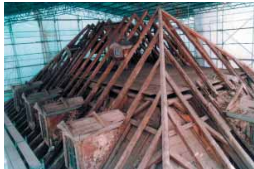
ABB. 14 Schloß Tiefurt, Dach während der Sanierung
