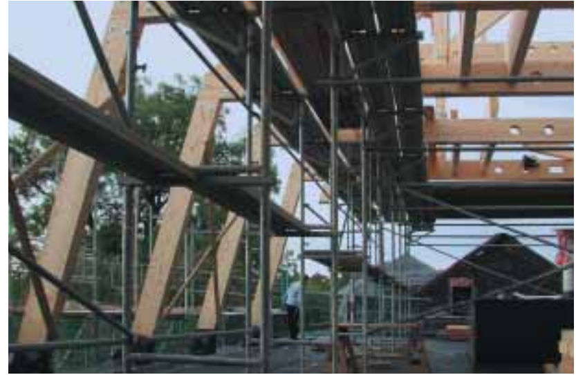
ABB. 4 Dachstuhlarbeiten auf der Brandebene der Herzogin Anna Amalia Bibliothek, September 2005
