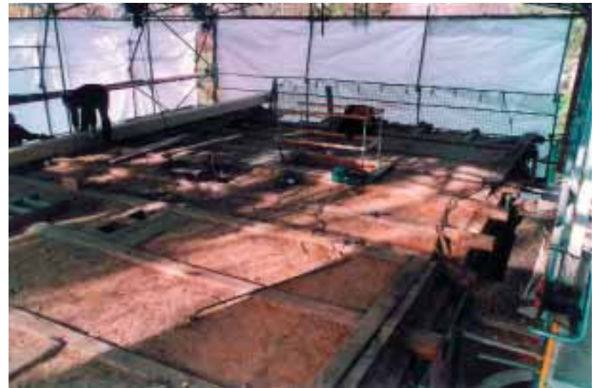
ABB. 18 Pogwischhaus, Sanierung der Decke nach der Demontage der Dachkonstruktion
