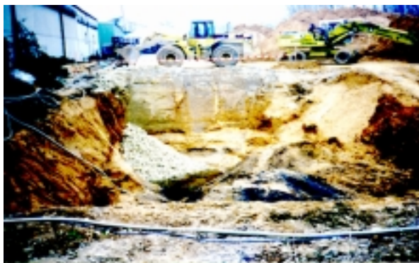
Sanierung einer Teerverunreinigung im nördlichen Landkreis Heilbronn durch Bodenaustausch
