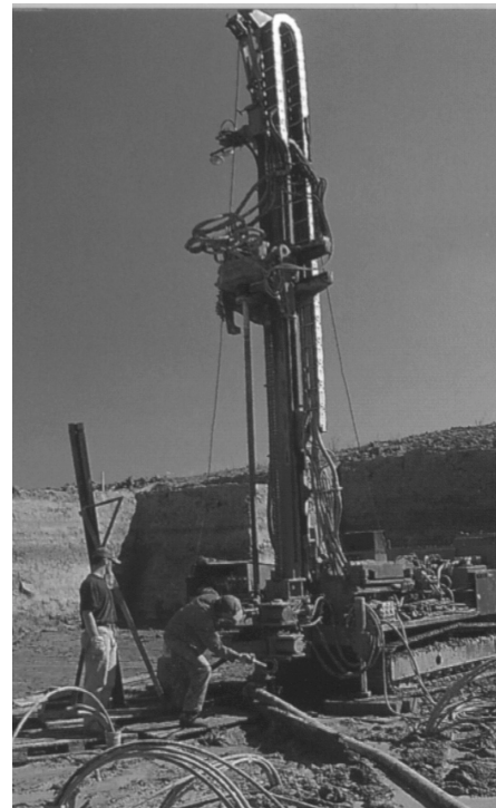
Bohrgerät im Einsatz
