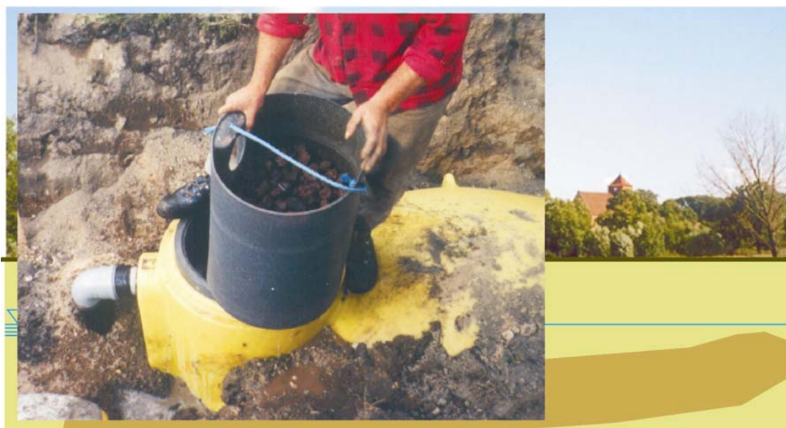
Rys.14 Filtr doczyszczający, montaż
