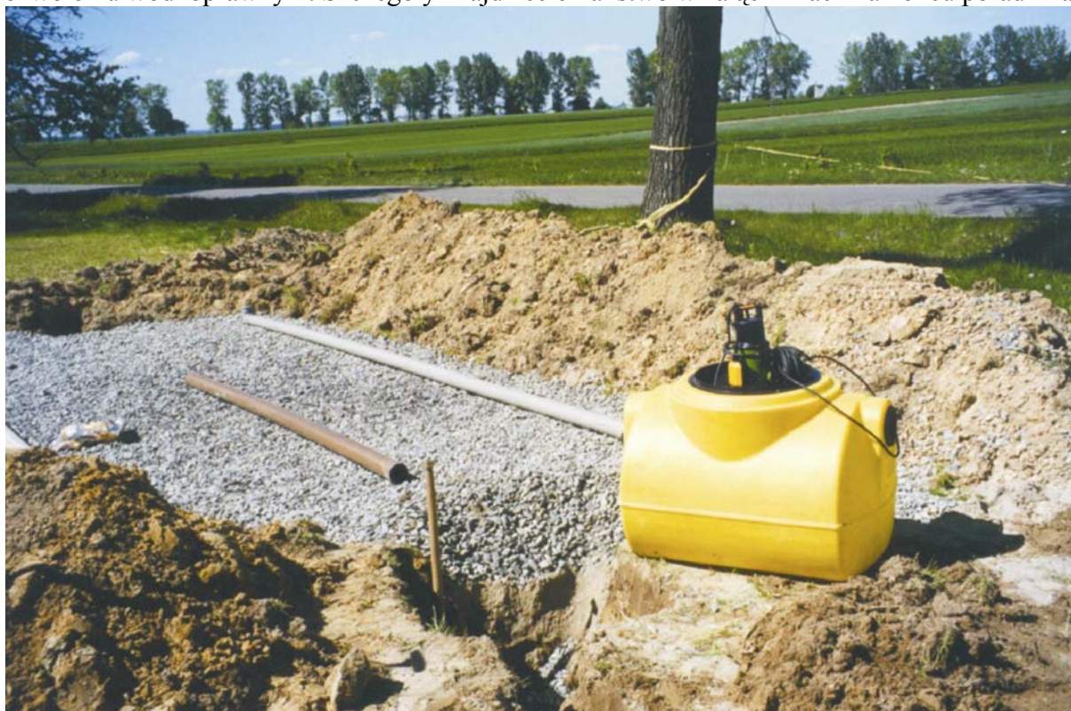
Rys. 21 Oczyszczalnia z filtrem piaskowym (pionowym) w trakcie montażu (Bukowina Kolonia, gm. Biszczka), w pierwszym planie pompownia ścieków
