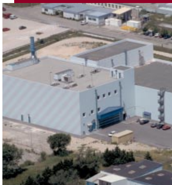
Vue de l'entreposage intermédiaire polyvalent (EIP) COGEMA Marcoule
