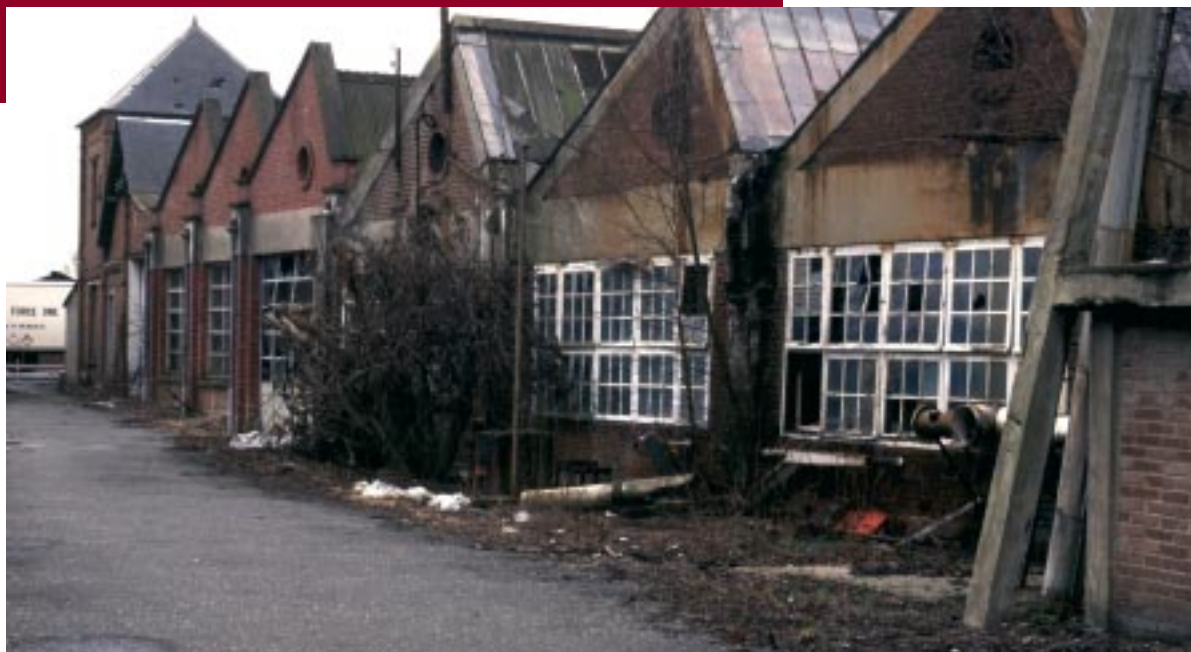
Décontamination des anciennes usines Bayard à Saint-Nicolas-d'Aliermont
