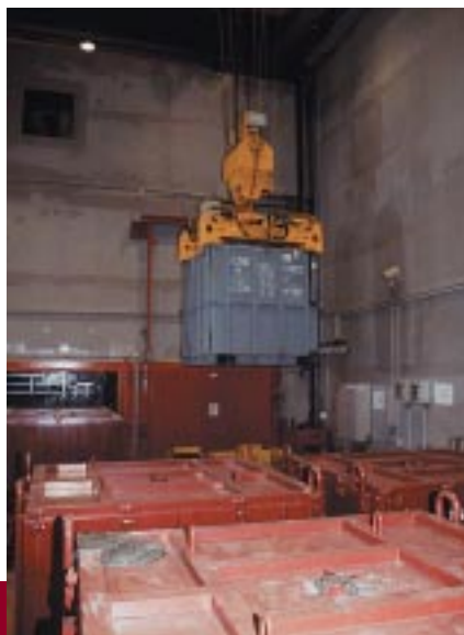
Caissons métalliques de déchets solides (amont du cycle)
