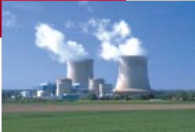
Centrale de Saint-Laurent-des-Eaux
