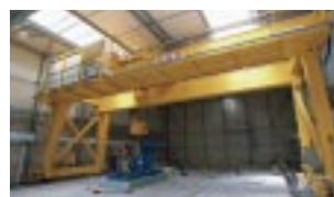
Chantier CEDRA (bâtiment M1) en mars 2005
