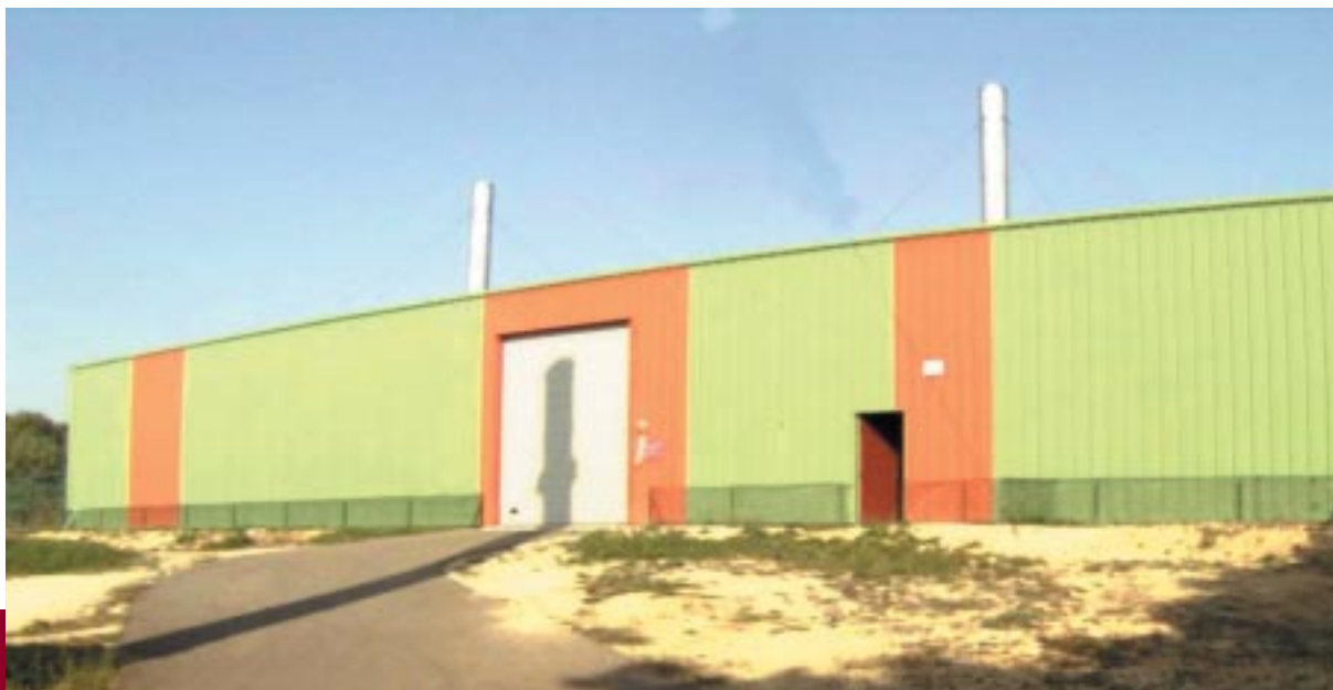
Entrepôt de déchets tritiés à Valduc
