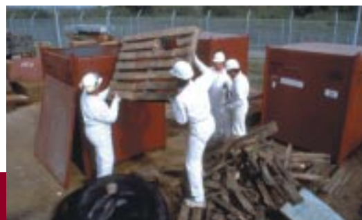
Démantèlement de la Centrale de Brennilis
