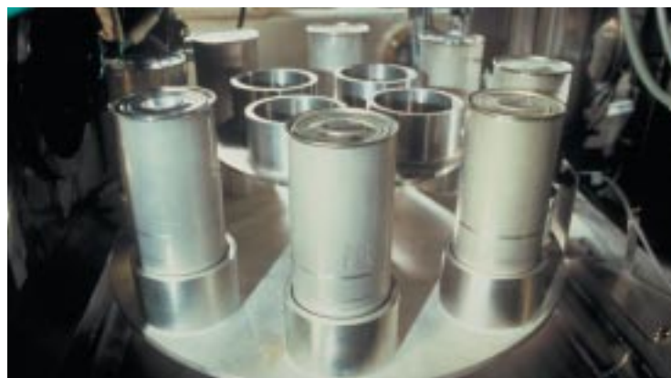
Carrousel des boîtes de plutonium Usine de fabrication de combustible MOX Melox COGEMA Bagnols-sur-Cèze
