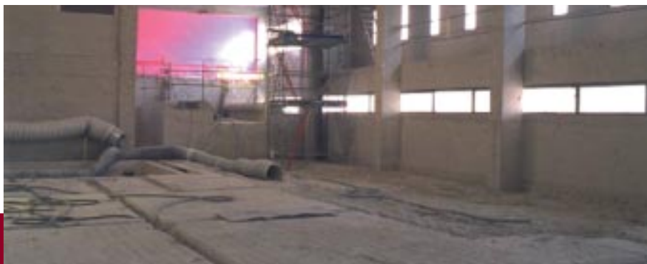
Démantèlement de la Centrale de Brennilis
