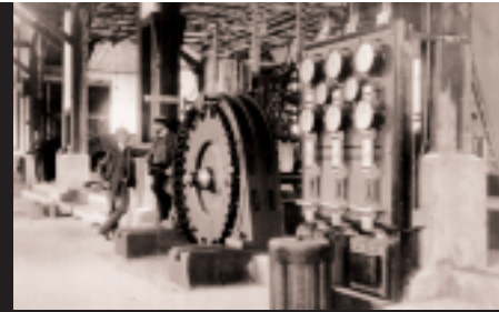
Laufen am Neckar, premier transfert de courant, 1891
