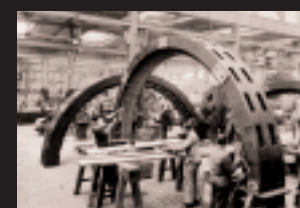
Montage de générateur, 1895
