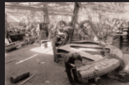
Montage de générateur à Baden, 1895
