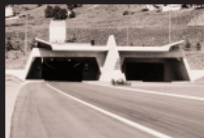
Portail sud de tunnel routier du Gothard avec technique de contrôle-commande BBC vers 1982
