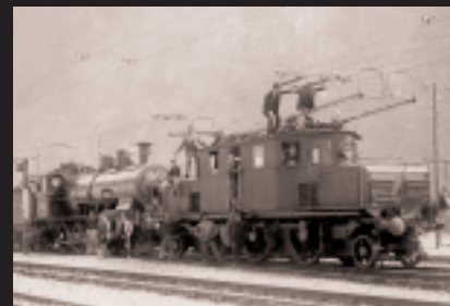
Electrification du tronçon du Simplon, 1908
