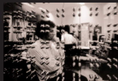
Laboratoire de test pour les systèmes de contrôle-commande
