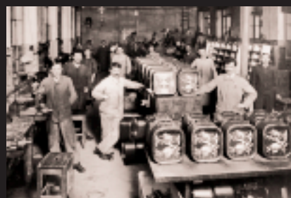
Montage von Spannungsreglern um 1910
