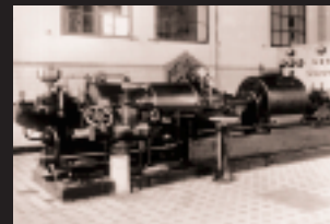
Erste BBC-Dampfturbine, 1901
