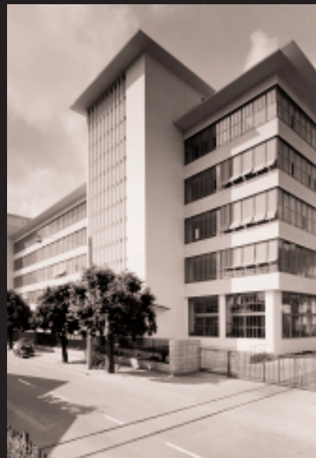
Die neue Turboladerfabrik, 1953
