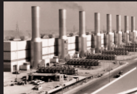
Gasturbinenkraftwerk «Riad 8», Saudi-Arabien
