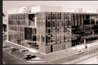
Bürogebäude Toro 1, Zürich-Oerlikon
