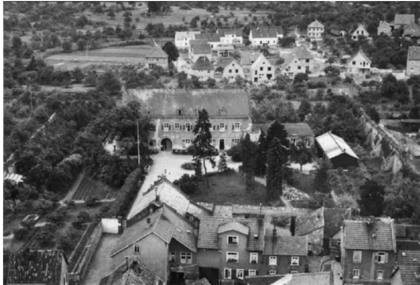
Schlossanlage um 1960 Die Häuser in der Wüstenrotstraße befinden sich im Bau
