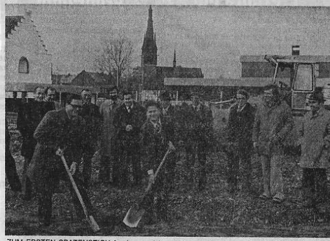
ZUM ERSTEN SPATENSTICH fand man sich auf dem Gelände der nun entstehenden Schulsporthalle ein. Am Spaten betätigen sich Stadtbürgermeister Bischof (links) und Verbandsbeigeordneter Fels. Bild: Elvers
