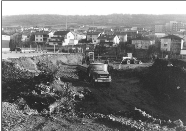
Baugrube zum Bau der Sporthalle 1980
