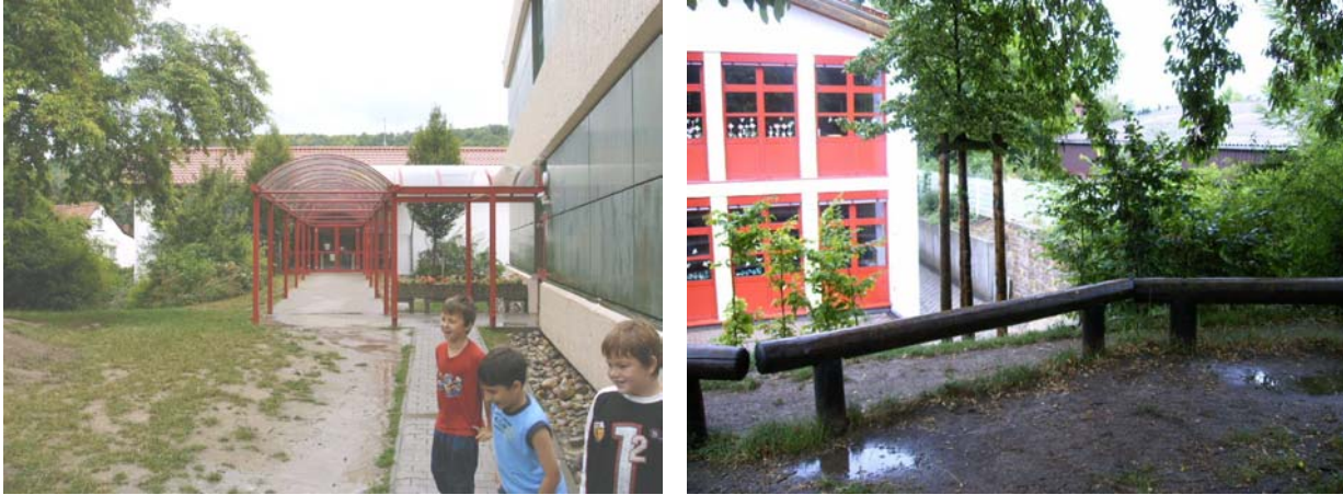
Erweiterung der Grundschule Auf dem Bild unten rechts kann man die Mauer zur Schlossmühle erkennen.
