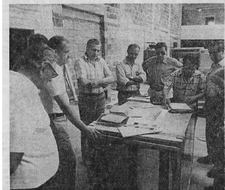
DIE ROHBAUARBEITEN an der neuen Gau-Algesheimer Sporthalle sind abgeschlossen. Der Verbandsgemeinde-Ausschuß für Planung, Wirtschaft und Verkehr überzeugte sich an Ort und Stelle über den Stand der Bauarbeiten (unser Bild) und ließ sich von Architekt Walter Vorschläge zur farblichen Gestaltung der Inneneinrichtung unterbreiten. Für die plangemäße Ausführung der Arbeiten sprachen die Vertreter der Verbandsgemeinde der Baufirma großes Lob aus und dokumentierten ihren Dank mit zwei Kästen Bier für die Bauarbeiter. Endgültig fertiggestellt wird die Turnhalle mit dem Restaurant mit Ablauf dieses Jahres. AZ 19.8.80 Bild: Elvers
