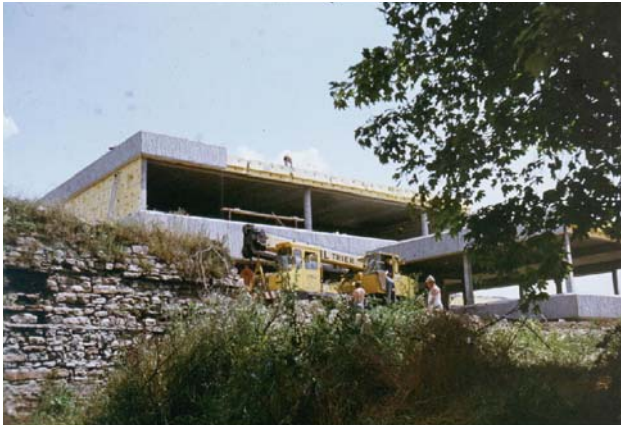
Fertigstellung des Rohbaues von der alten Schlossmauer aus gesehen.
