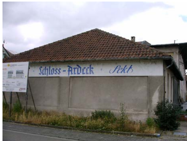
Nebengebäude der ehemaligen Kellerei Schweickert in der Bahnhofstraße
