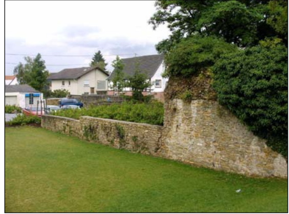
Mauern zur Badstube hin
