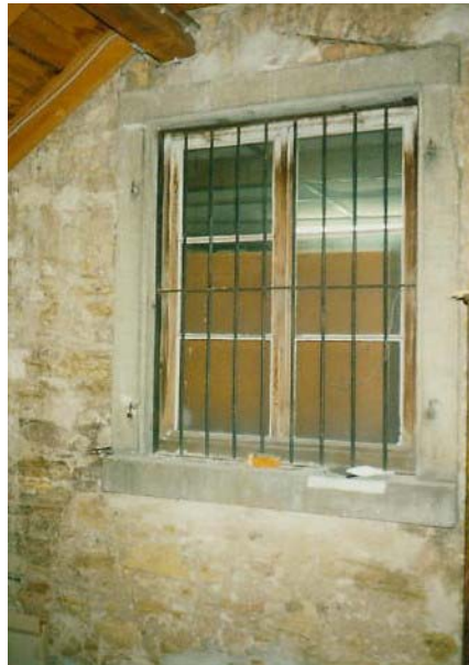
Ehemaliges Fenster am Nordgiebel vor dem Anbau und dessen Aufstockung
