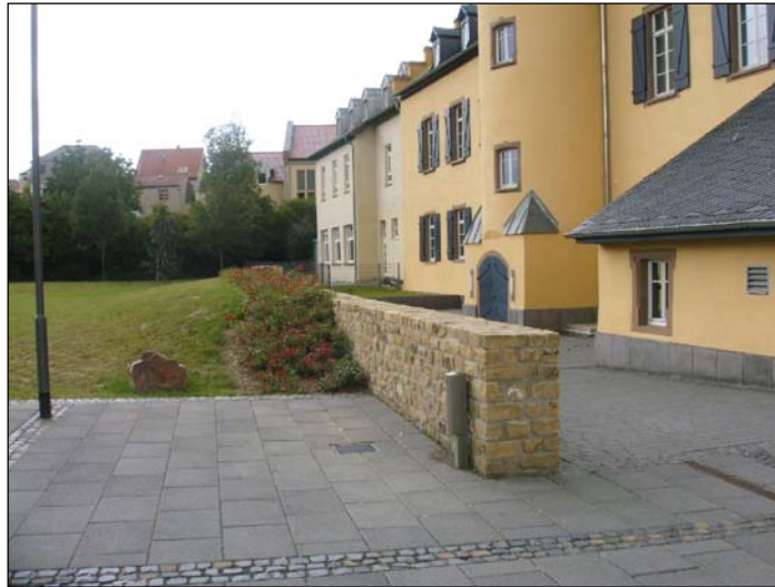
Reste der Grundmauern des Südflügels mit noch vorhandenen Kellereingang
