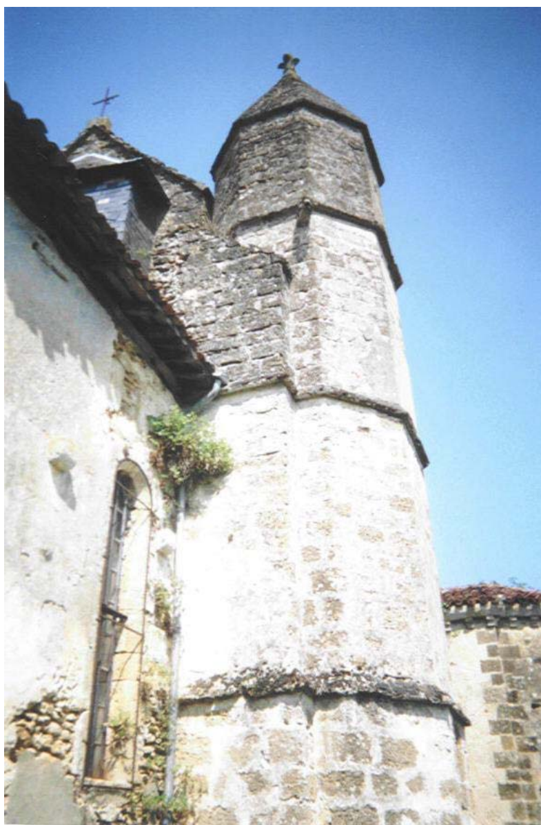
Tourelle d'escalier polygonale de l'église Saint Jean-Baptiste de Ponson.
