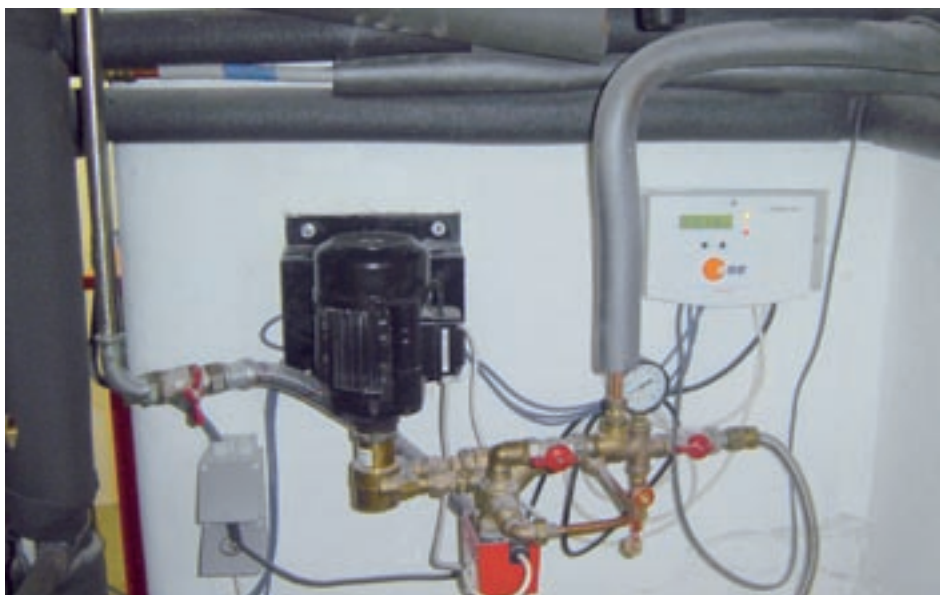
Een vooraf gemonteerde, bekabelde en ingestelde interface beheert het volledige systeem.
