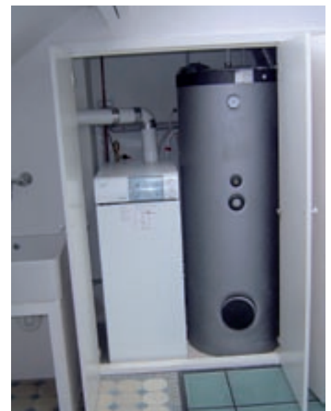
Ketel met een vermogen van 25 kW en opslag van 300 liter SWW
