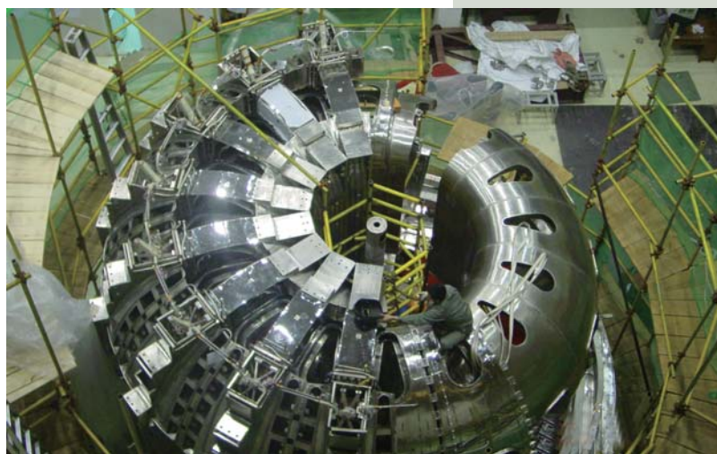
正在建设中的超导托卡马克核聚变实验装置
