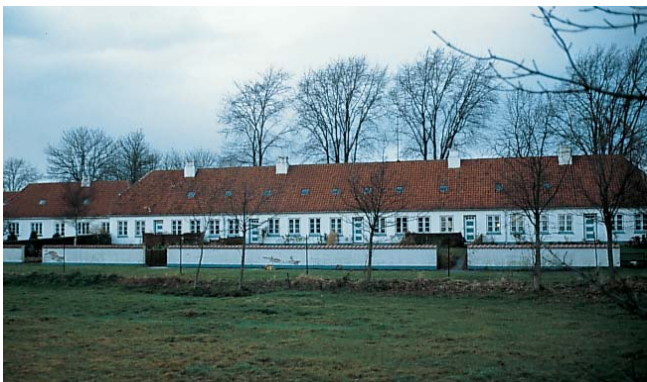
Arbejder- og håndværkerboliger
