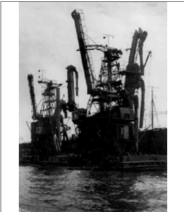
Abb.35 o.T.(Baggerschiff bei Rostock), 1937
