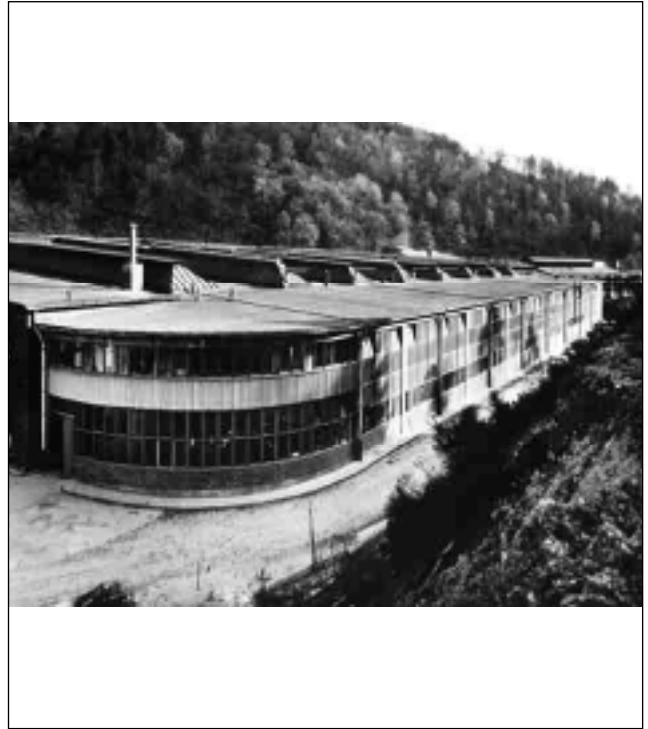
Abb.134 Ruth Hallensleben, Schmidt + Clemens, Anbau Gießereihalle, 1964, © Schmidt + Clemens GmbH + Co KG
