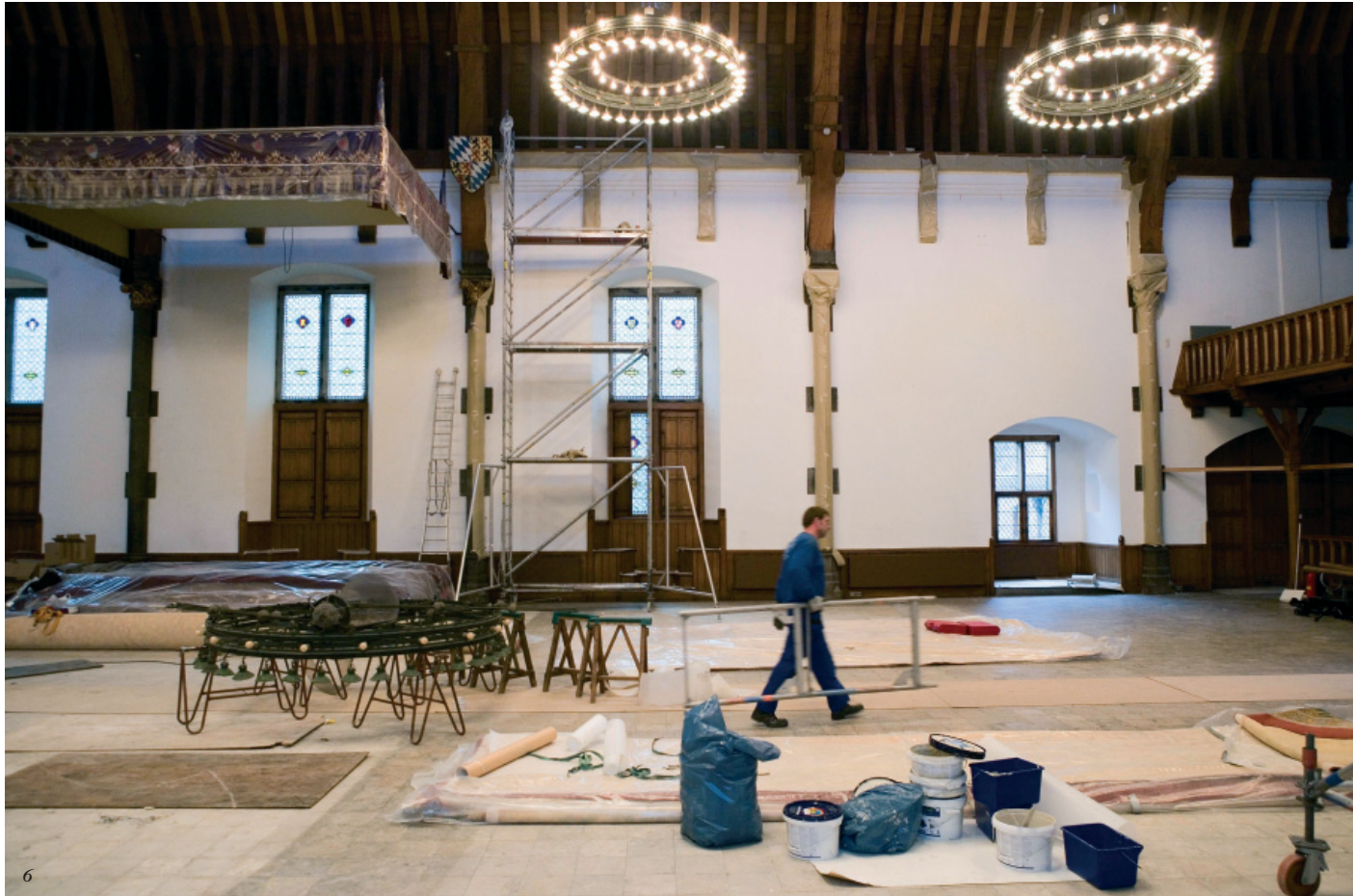
6) 2006: schilderwerkzaamheden en proeven kroonluchter tijdens renovatie
