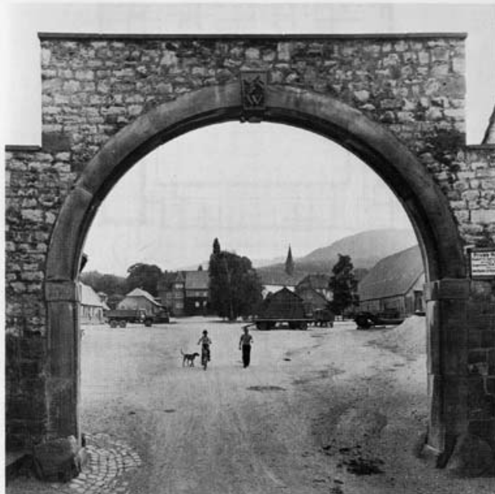
Blick in den Klostergutshof von Norden
