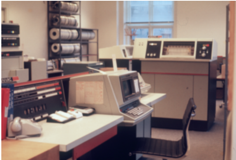
Maskinstuen set i retning mod Blegdamsvej. I forgrunden ses operatørkonsollen og i baggrunden en hurtig linjeskriver.
