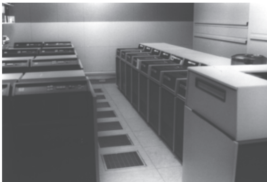
CDC-maskinen i RECAUs maskinstue på Aarhus Universitet. Til højre ses pladelager med udskiftelige plader, og forrest ses et hjørne af printerens. Til venstre ses pladelager med faste plader.
