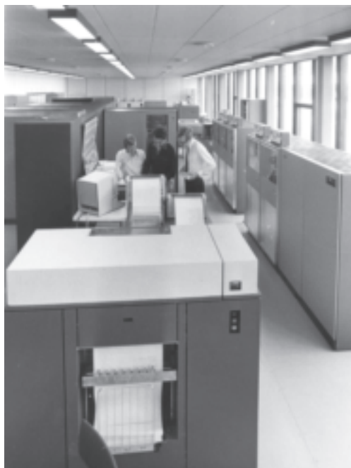
Maskinstuen i bygn. 308 med IBM 360/75 konsollen, båndstationer og printer.
