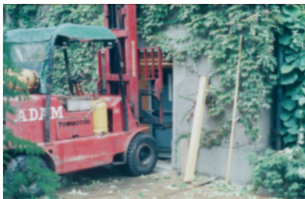
Gennem et hul i ydermuren i maskinstuebygningen på Blegdamsvej er en FASTRAND-tromle ved at blive anbragt i kælderen.
