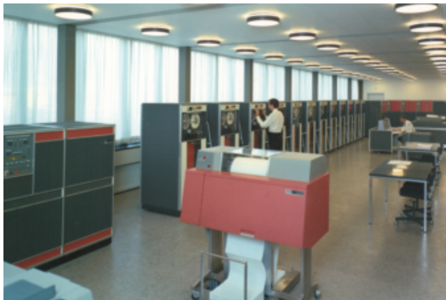
Den første maskinstue i bygn. 305 var præget af de mange båndstationer, der var 7090-maskinens eneste forbindelse til omverdenen. Indlæsning af hulkort og udskrift af print og plot foregik på en separat "lille" IBM 1401-computer, der ses til venstre i billedet.
