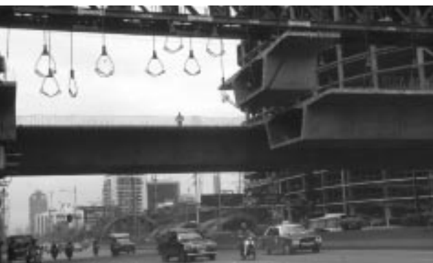
Abb.1 Bau einer Segmentbrücke
