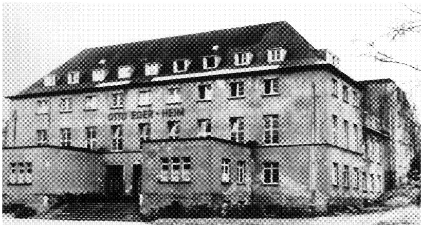
Abb. 104: Notdürftig wieder aufgebautes Otto-Eger-Heim um 1950, im hinteren Gebäudeteil noch ohne Bedachung (PrivA Weidemann).
