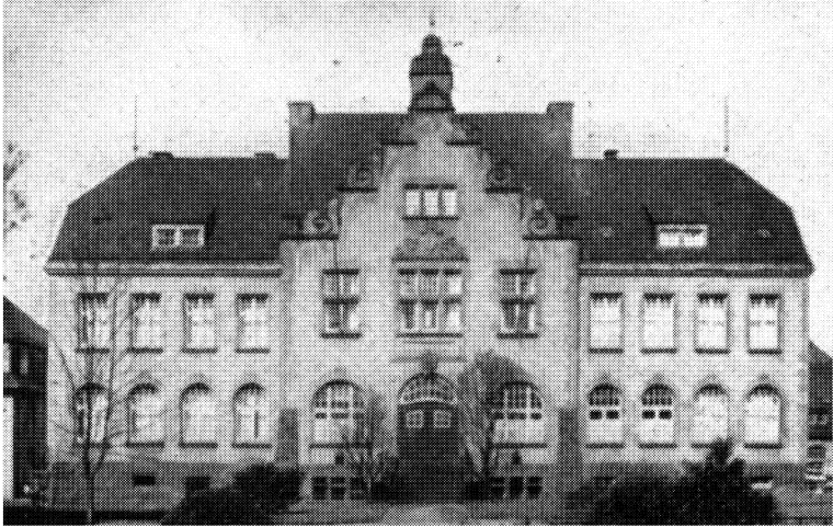
Abb. 2: Verwaltungs- und Auditoriumsgebäude der Veterinärmedizinischen Fakultät um 1932, Ansicht von der Frankfurter Straße (DTW 40, 1932).
