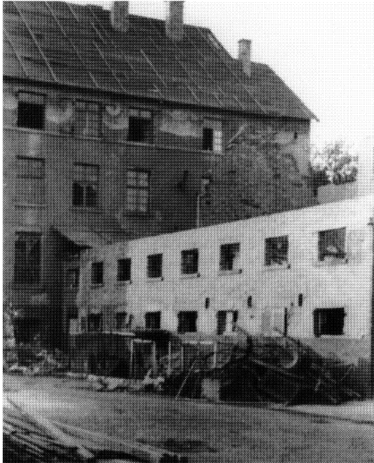
Abb. 67: Das zerstörte Veterinäruntersuchungsamt in der Marburger Str. 54 mit dem Institut für Tierärztliche Nahrungsmittelkunde im oberen Stockwerk (Besse 1992). 24
