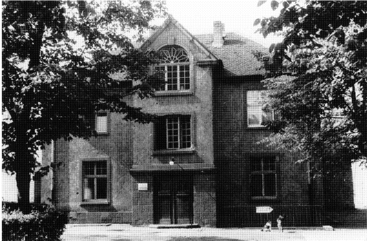
Abb. 80: Wieder aufgebaute alte Ambulatorische und Geburtshilfliche Veterinärklinik, 1954, Nordostfront (UAG Dez E2 K. 97 "Baubedürfnisse ...").
