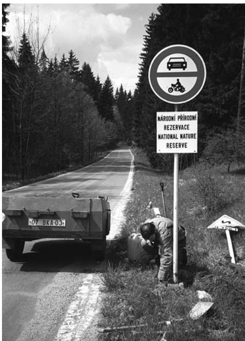
Instalace dopravní značky „Zákaz vjezdu motorových vozidel“ v Suchém žlebu Foto L. Štefka
