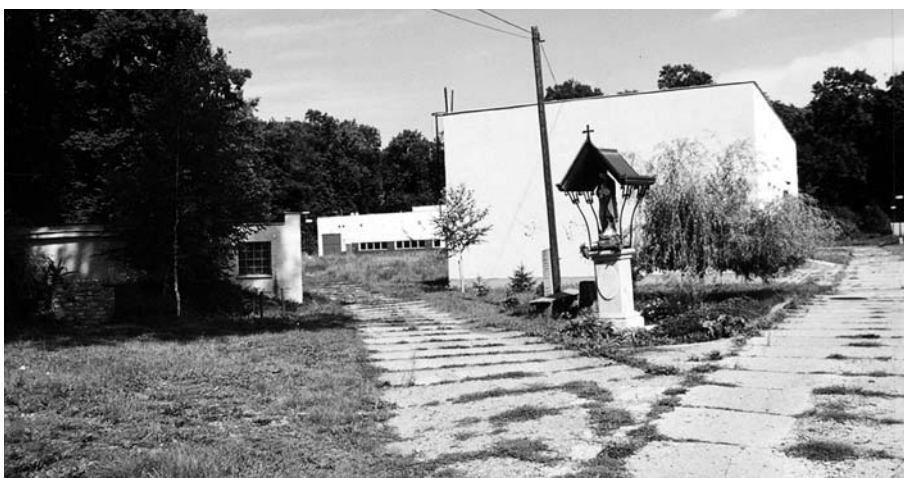
Velkým problémem pro vodní režim lužních lesů jsou vodárenské odběry podzemní vody ze štěrkopískových sedimentů. Na snímku vodárenský objekt „Čerlínka“ v CHKO Litovelské Pomoraví, původně poutní místo u prameniště říčky Čerlínky, která byla vodárenskými odběry téměř zlikvidována
