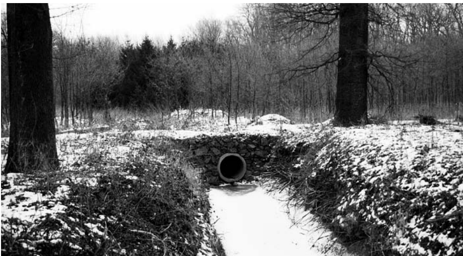
Na některých místech byla periodická říční ramena v CHKO Litovelské Pomoraví přerušena po výstavbě lesní cesty. V rámci revitalizačního programu bylo nutno vybudovat nové trubní propustky za účelem opětovného zprůtočnění ramene. Na snímku Stará Morava u Štěpánova, 1999
