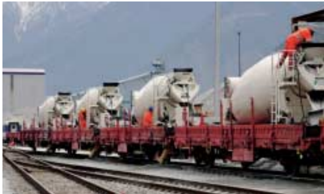
8 Betonzug am Installationsplatz (IP) Raron
