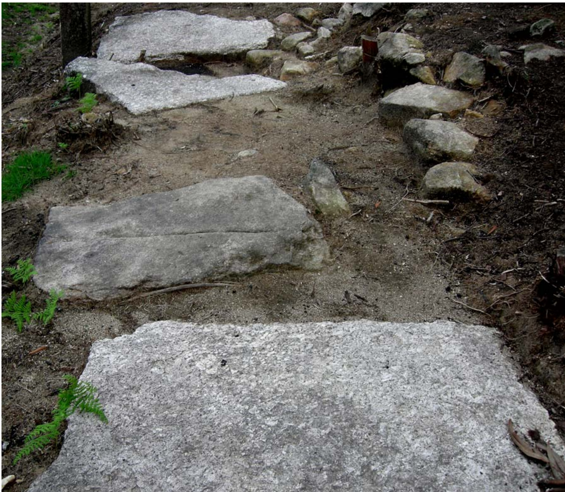
5. Pavimento da câmara
