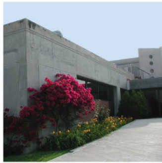
バイオテック研究棟玄関
