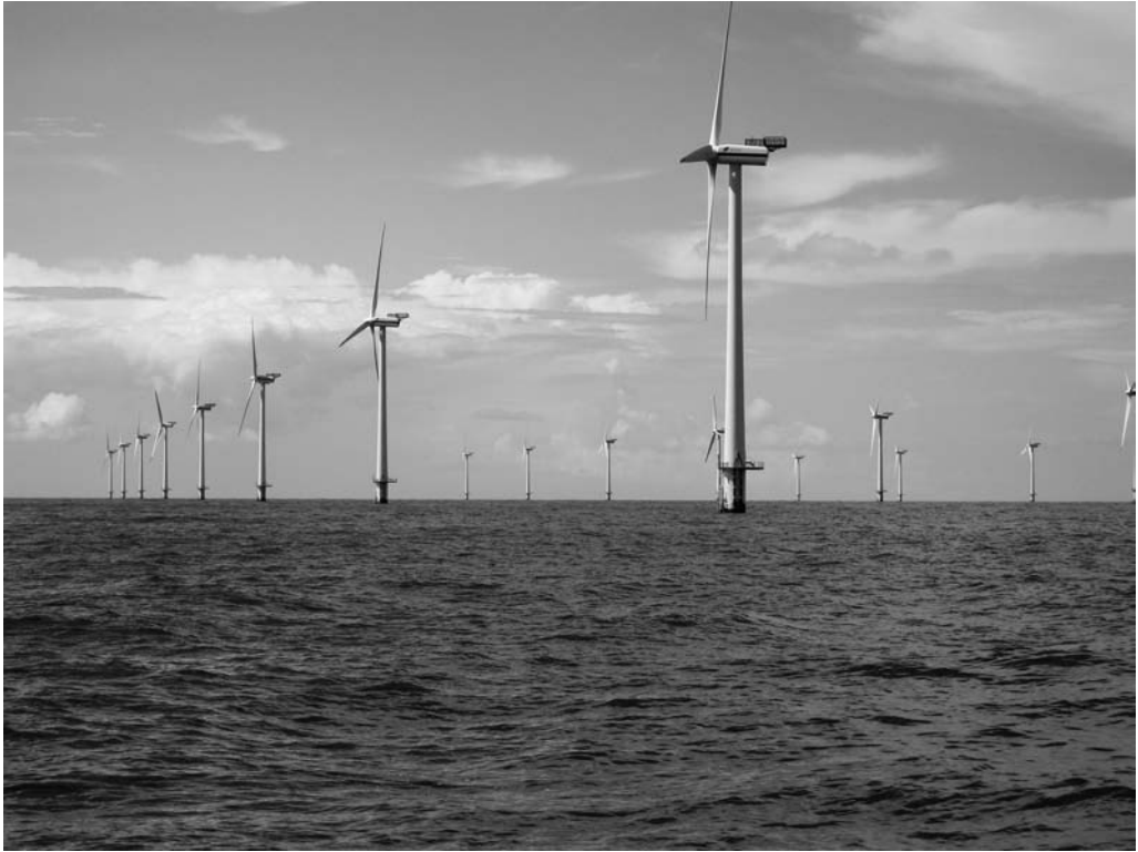
Vindmøllepark ved Horns rev i Nordsøen i 2002. Parken består af 80 møller, som hver har en kapacitet på 2 MW
