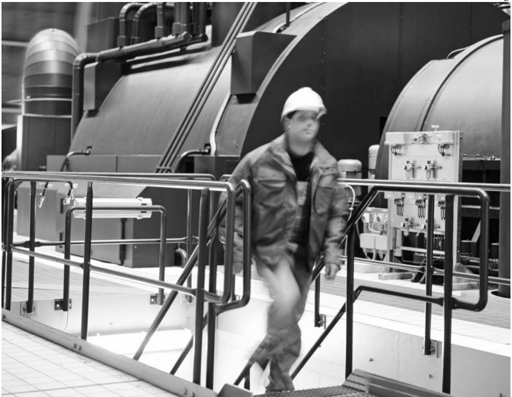
Fra maskinhallen på et stort el-værk. Medarbejderen er muligvis på vej ud efter en personalerationalisering foranlediget af el-liberaliseringen.
