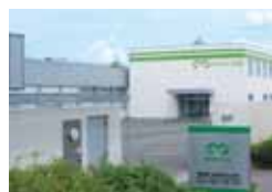
New plant, MEMS-Core Co., Ltd.
