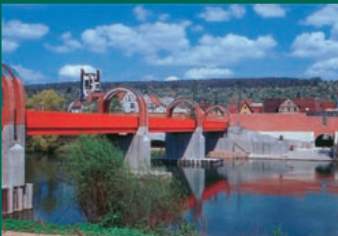
Plochingen 1998: Im Zuge der Gartenschau wurde das Fuß- und Radwegnetz erheblich ausgebaut. Hier der Bau des neuen Neckarsteiges.
