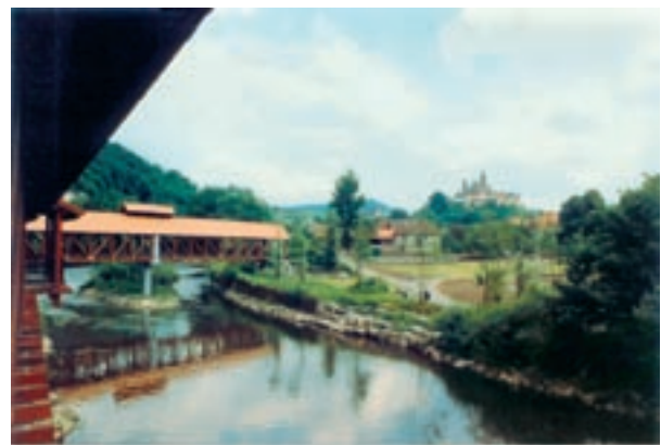
Neuer Fußgängersteg über den Kocher
