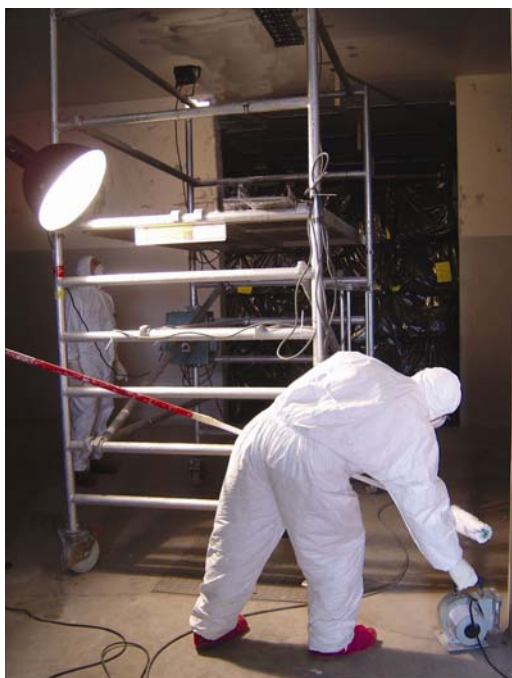
Slika 8: Zaščitna obleka za delo v področju, kjer so zrak in površine močno kontaminirani.
