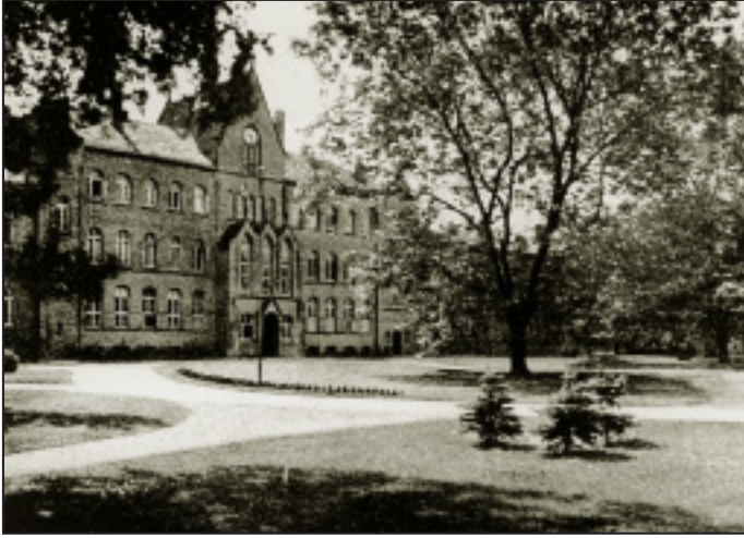
Innenhof der Heil- und Pflegeanstalt Göttingen (erbaut 1864/1866)
