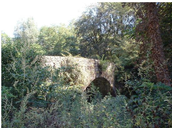
Ponte medievale di Carrodano
