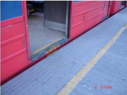
Figur 7.2 Taktil og visuell merking i overgangssonen mellom tog og perrong.
