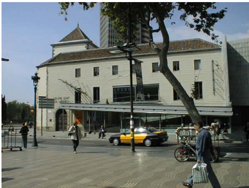
Figur 4.5 Man har lagt en ny bygning i en etasje inntil den gamle.
