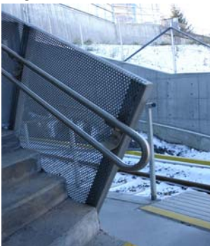
Figur 7.14 Avslutning av trapp og rekkverk.
