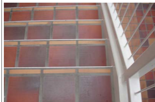
Figur 5.11 God funksjonell og estetisk kontrastmerking i trapper.
