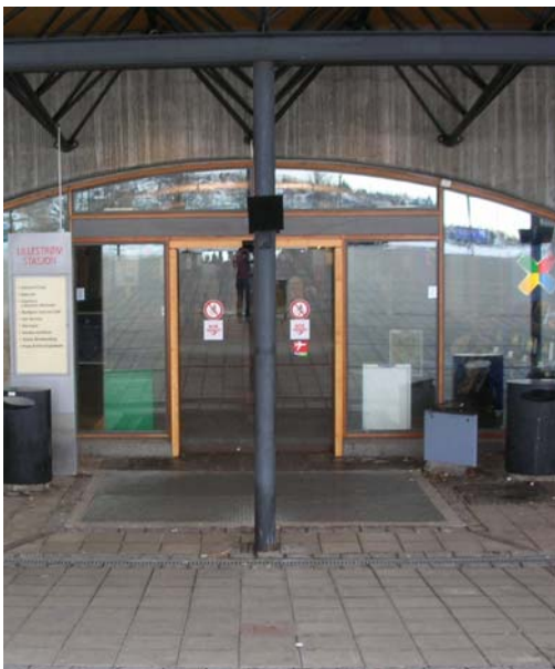
Figur 7.26 Denne søylen er plassert rett foran inngangspartiet fra Sydplassen. Slike elementer bør ikke forekomme i gangbanen.
