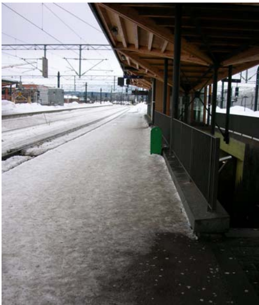
Figur 7.19 Markeringene av perrongkantene forsvinner under snøen, noe som fører til at perrongene er uten visuelle og taktile markeringer på vinteren.
