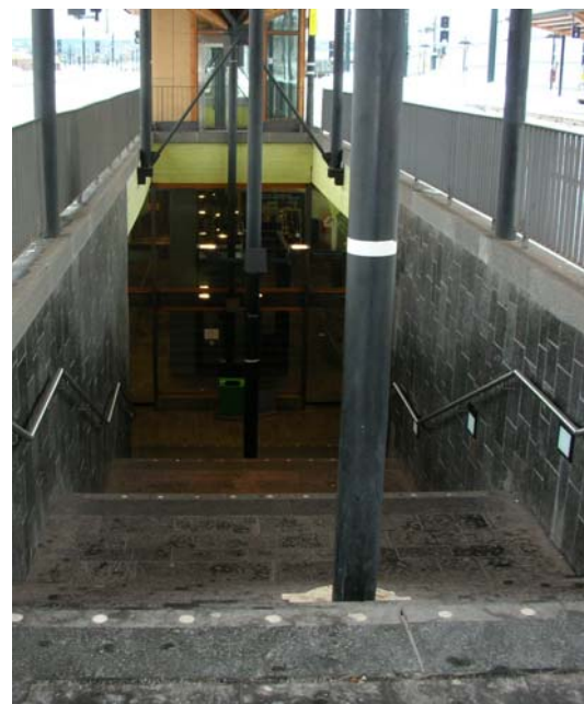
Figur 7.17 Bildet viser trappen ned fra en av perrongene. Plasseringen av søylene er lite heldig både for synshemmede og andre brukere.
