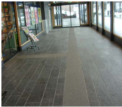
Figur 7.13 Stripen i underlaget viser retningen på gangbanen.
