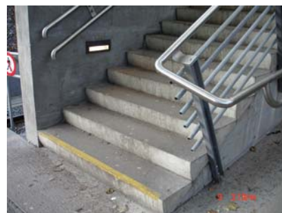
Figur 7.10 Avslutning av rekkverk.
