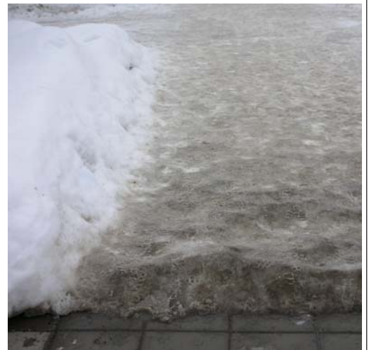
Figur 7.28 Høye kanter av is har lett for å oppstå i overganger mellom underlag med og uten varmekabler. Slike kanter kan bli hindringer og snublekanter. Dette bildet viser overgangen mellom Sydplassen og fortauet utenfor plassen.
