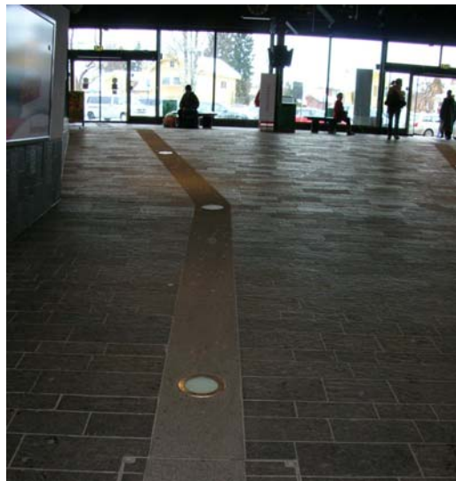
Figur 7.14 Noen retningsendringer kunne vært unngått. Bildet viser gangretningen mot inngangspartiet i nord.
