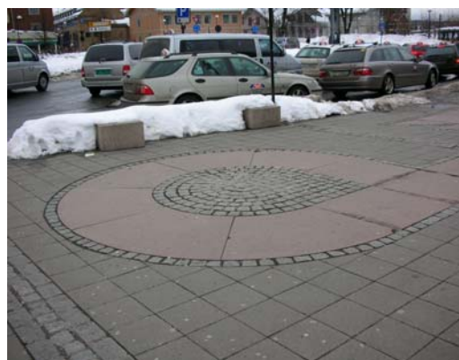
Figur 7.24 Da det er meningen at synshemmede skal kunne bruke mønsteret i underlaget til å orientere seg bør mønstere som dette unngås.
