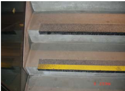
Figur 7.4 Kontrastmerking i trapp.
