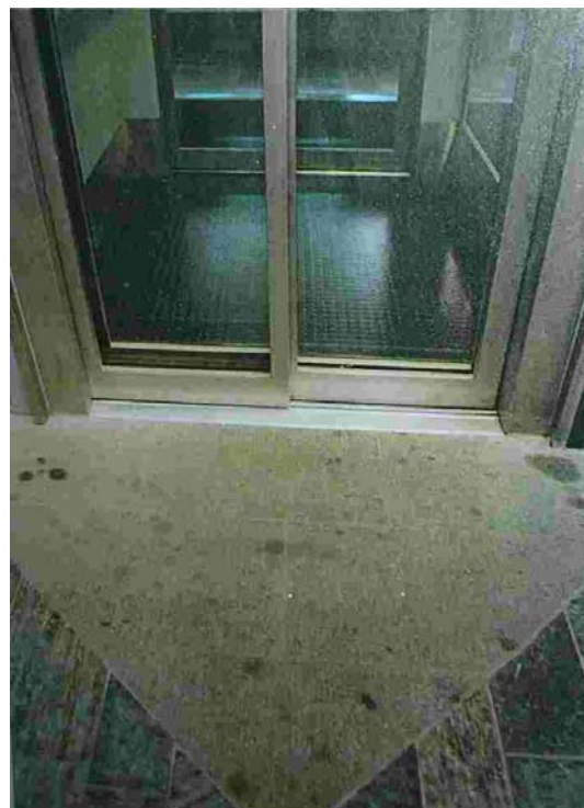
Figur 7.16 Bildet viser markeringene foran heisdørene. Denne markeringen burde kanskje vært i større kontrast til underlaget ellers.
