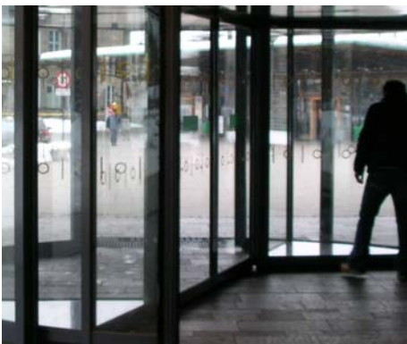
Figur 7.21 Karusell døren har markeringer i lysegule tynne sirkler og striper. Da karusell-dører er problematiske for mange bør spesielt slike dører ha gode markeringer.
