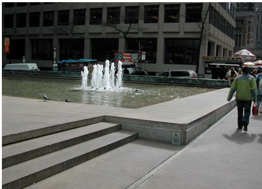
Figur 2.8 Seagram building på Manhattan i New York er en annen kjent og typisk bygning av Mies van der Rohe. Her er en beskjeden nivåforskjell som lett kunne vært tatt med en slak rampe
