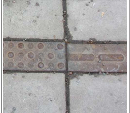
Figur 7.27 Her er oppmerksomhetsfeltet like bredt som retningsindikatoren. Slike felt bør være større, så man registrerer dem
