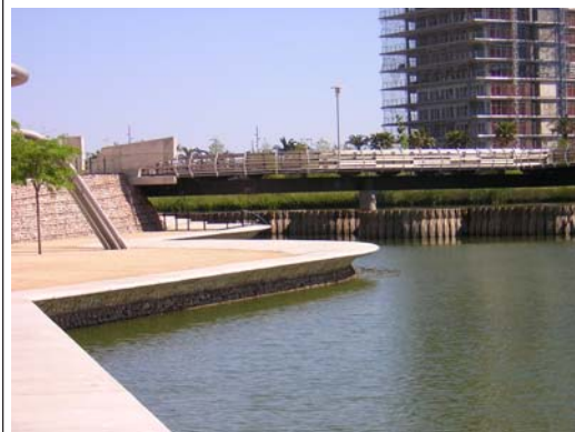
Figur 6.2 Slake stigninger til en flott utformet bro, gir en lett tilgjengelig utsikt over store deler av parken.
