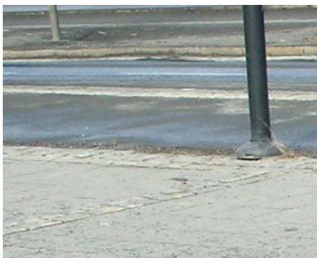
Figur 7.22 Bildet viser en linje med brøstein som skal kunne lede den syn- shemmede ut til kantsteinen. Her leder denne linjen rett i en lyktestolpe.
