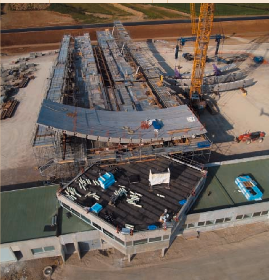
A terme, l'auvent mesurera 98 mètres de long, 28 de large, et pèsera 2 400 tonnes.
