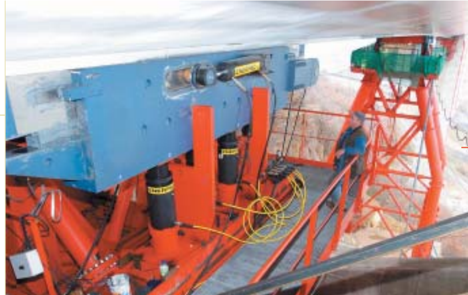
C'est grâce aux translateurs que les milliers de tonnes du tablier peuvent être soulevées et déplacées.
