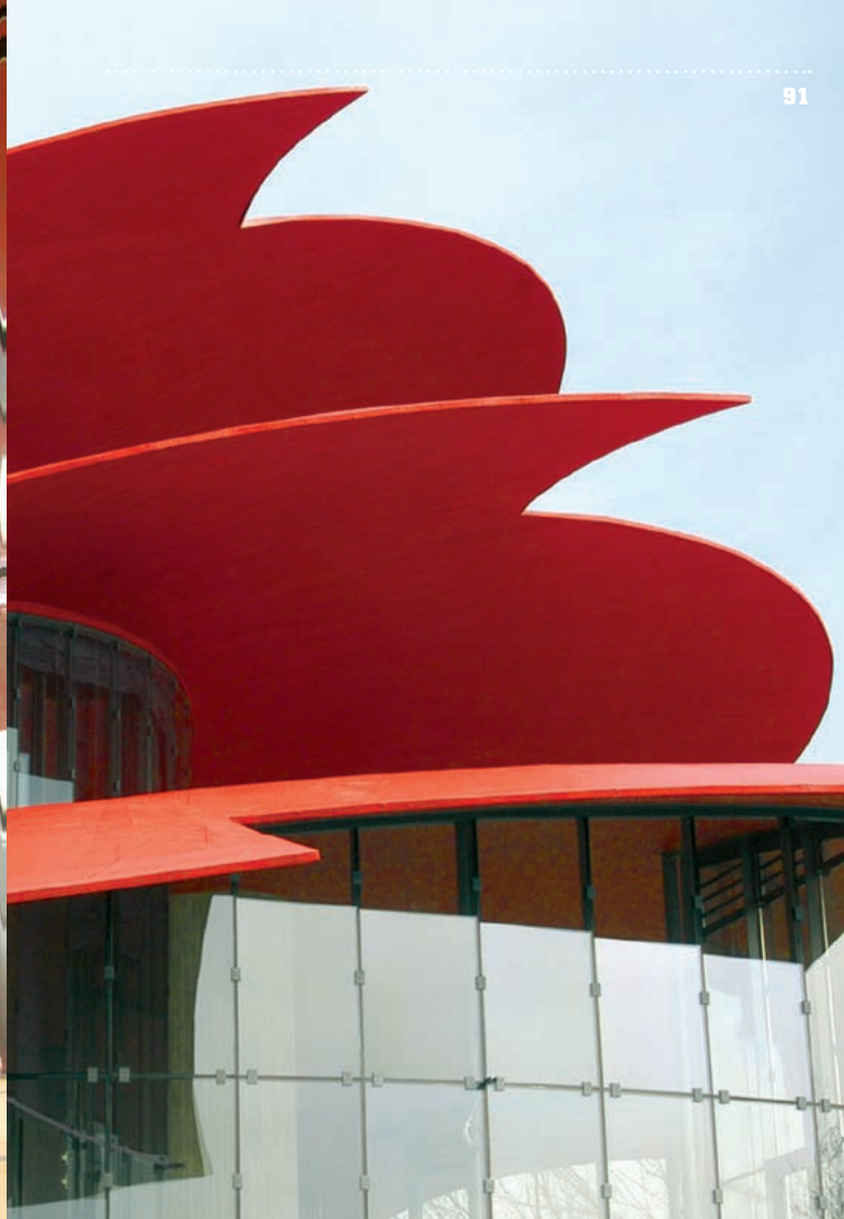
Blick unter die »Dach-Flügel«
