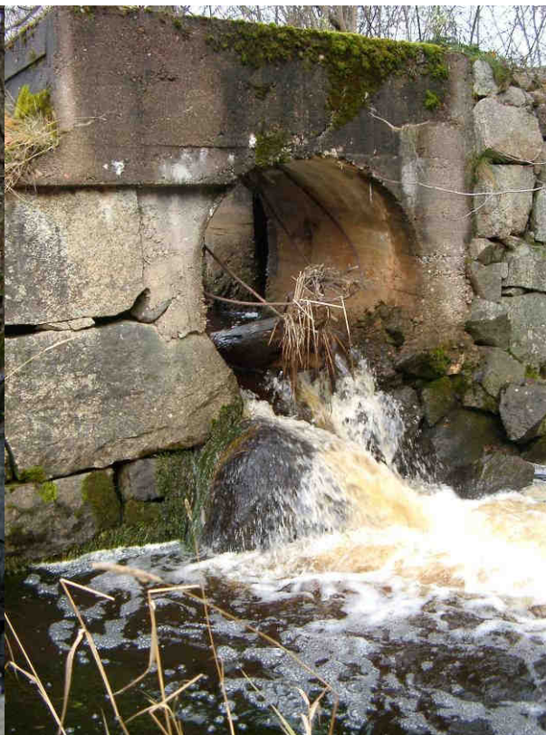
Foto 9. Röret genom norra delen av dammen. Höjs vattendjupet här kan öring passera förbi hindret vid normala flöden.
