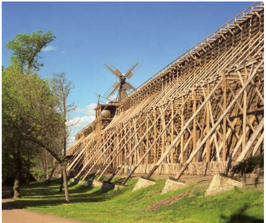
Um in der Saline von Schönebeck Brennstoff zu sparen, wurde die Konzentration der gewonnenen Salzsole im Gradierwerk von Bad Elmen durch Verdunsten auf 21 Prozent erhöht. Mit fast zwei Kilometern Länge war dieses Bauwerk das weltweit Größte seiner Art.
