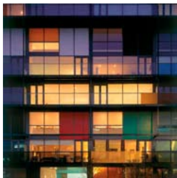
Abb. 40: Die Stimmung dieses Bildes soll auf den Style der Ausstellung übertragen werden.
